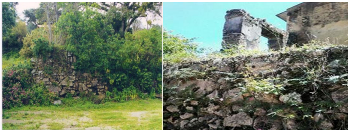
Figura 11. Muro no terreno ao sul da Igreja de São Joaquim de Garopaba, mesmo setor, em meados da década de 1990 e em 2015. Imagens de Fabiana Comerlato. Adaptado de Souza (2016).
