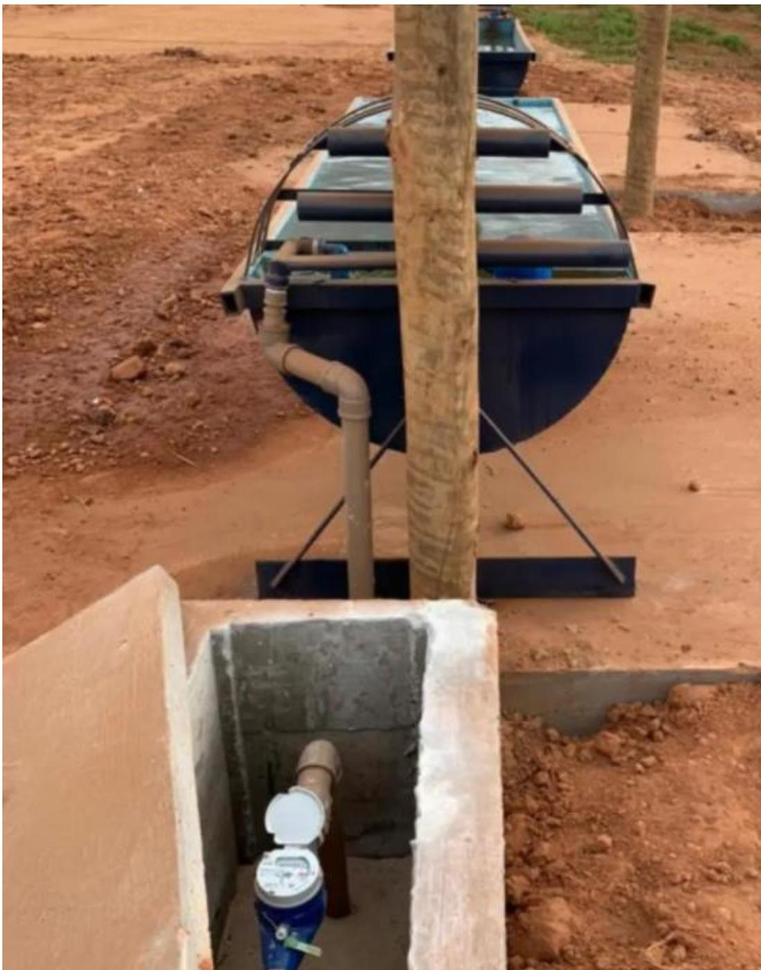
Figura 1: Hidrômetro em bebedouro, para controle de consumo de água.
