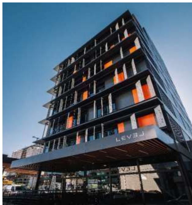
Figura 4 – Imagem do Edifício LEVEL, em Tubarão – SC.
