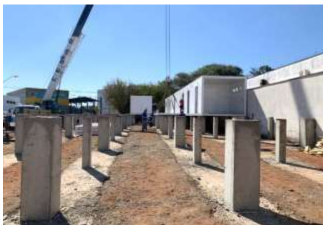
Figura 8b – Instalação de Módulos na obra de um Hospital na cidade de Piracicaba – SP
