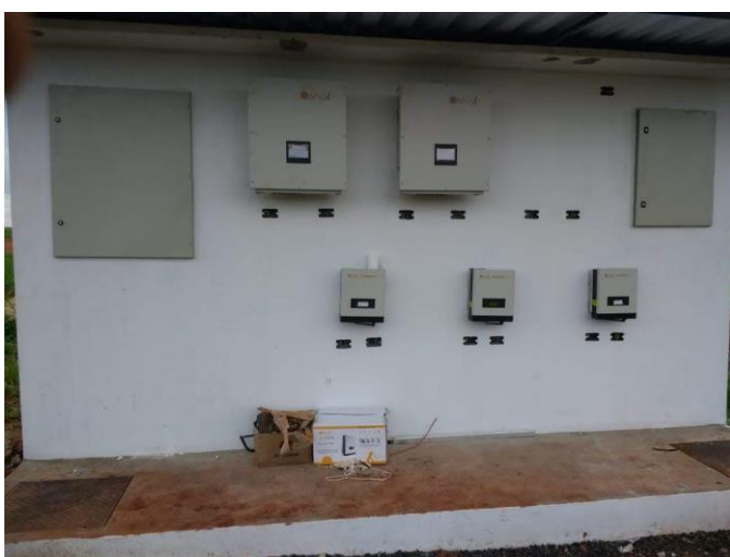
Fig. 8: Instalação dos Inversores
