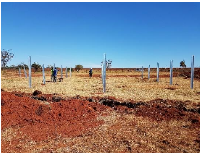
Fig. 7: Assentamento da base das estruturas dos módulos fotovoltaicos
