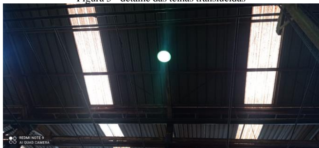
Figura 5 - detalhe das telhas translúcidas
