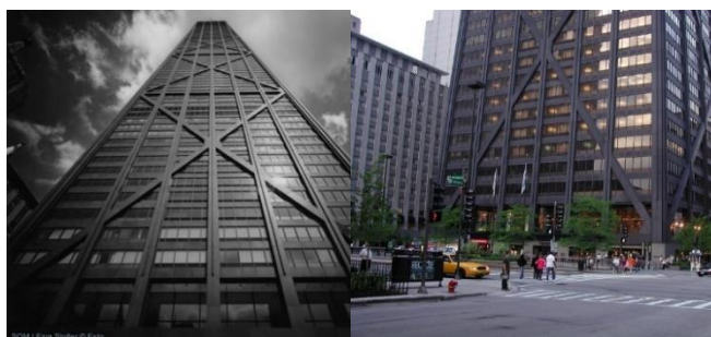
(a) Vista frontal do contraventamento
