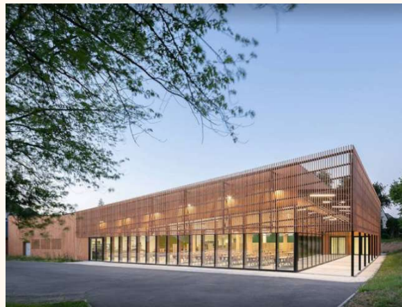
F.39 – Fachada com transparência
