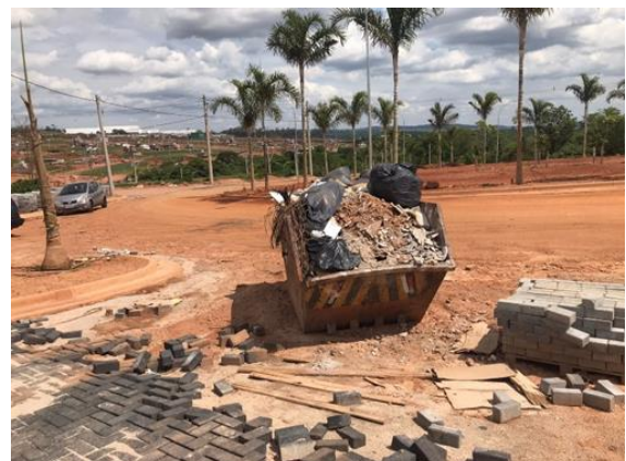
Figura 14 - Caçamba de entulhos
