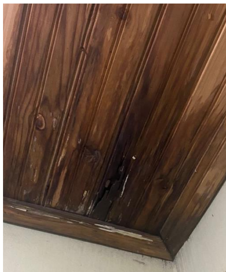
Figura 8 - Forro de madeira do escritório com deterioração por ação da água e agentes bióticos
