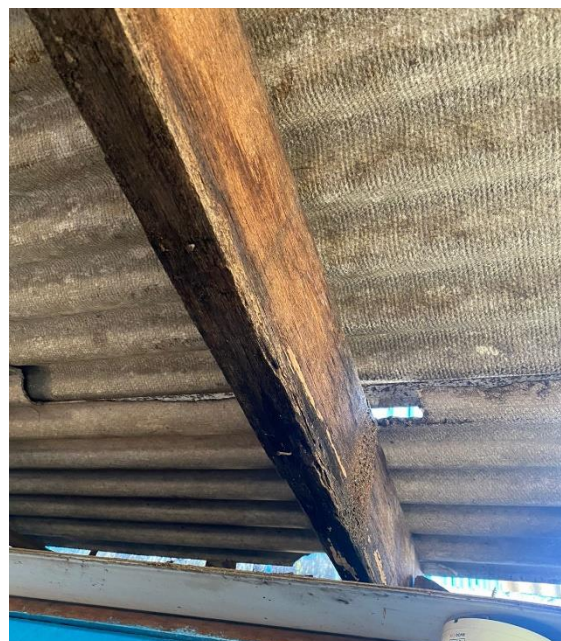
Figura 2 - Viga de madeira deteriorada pela ação da água e por agentes bióticos
