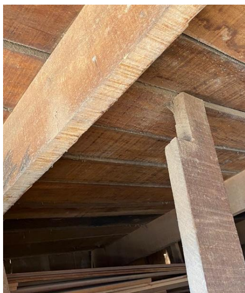
Figura 4 - Viga de sustentação de mezanino com ausência de peça de apoio
