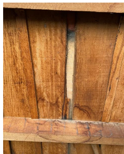
Figura 5 - Peça de piso de mezanino com deficiência no dimensionamento e com manchamento por ação da água.
