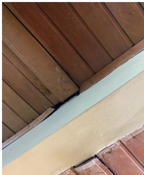
Figura 3 - Deterioração pela ação da água e agentes bióticos em forro de madeira
