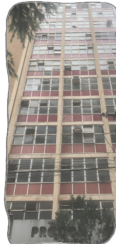
FIGURA 06 - EDIFÍCIO SUBUTILIZADO NO ST. CENTRAL, GOIÂNIA; FONTE: AUTORA
