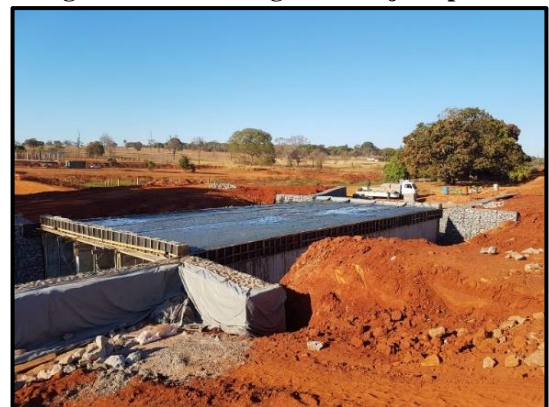
Figura 16: Concretagem da Laje Superior
