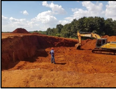
Figura 5: escavação do bueiro
