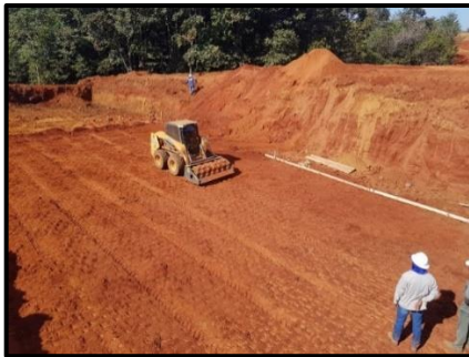
Figura 6: Compactação do Solo
