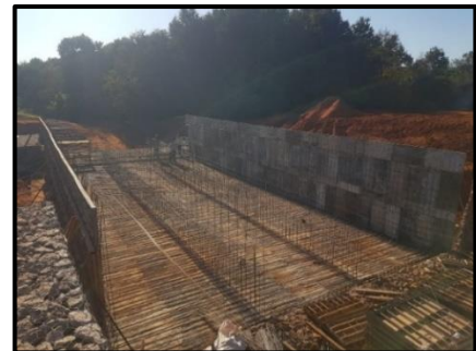
Figura 10: Armação da Laje Inferior
