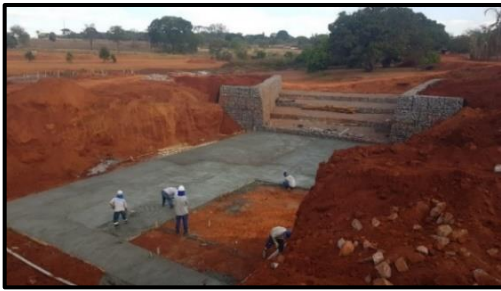
Figura 8: Concretagem do Lastro
