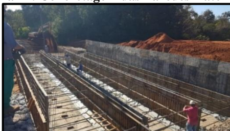
Figura 12: Concretagem das Paredes – até 1,20m
