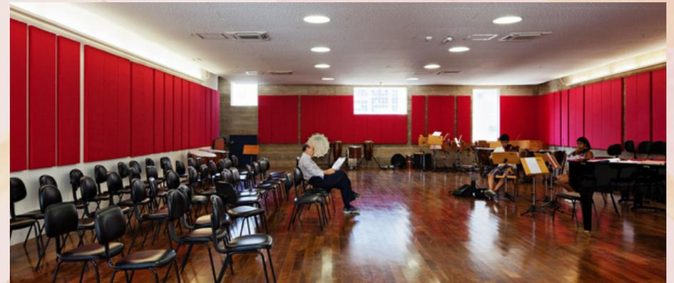
Por ser um edifício que a seu componente principal é o concreto, fazendo parte da sua estrutura formal e utilizado também com o aspecto estético, foram utilizados diversos elementos acústico que, por ficarem aparentes, foram integrados como elementos estéticos e se destacam por serem de cores e formatos variados
