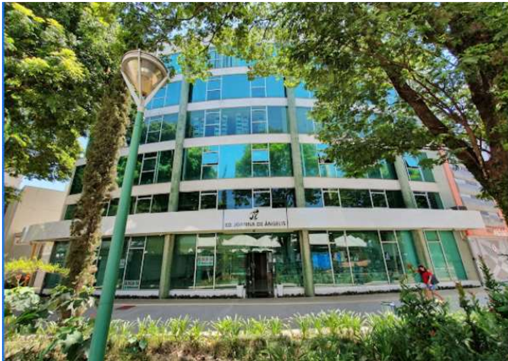
Figura 4 – Frente do Edifício
