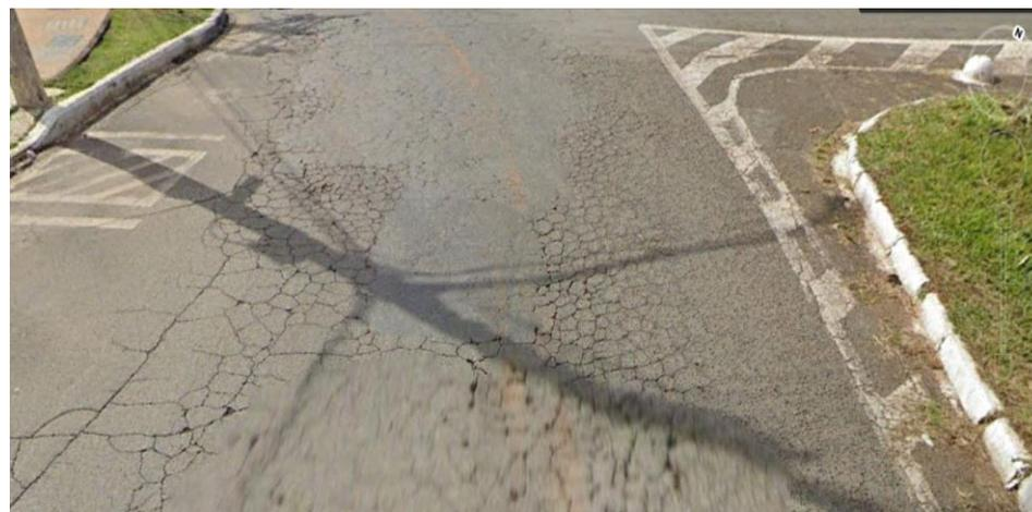
Imagem 30: Asfalto em condições precárias. Fonte: Google Earth Streetview.
