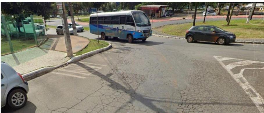
Imagem 29: Asfalto em condições precárias. Fonte: Google Earth Streetview.
