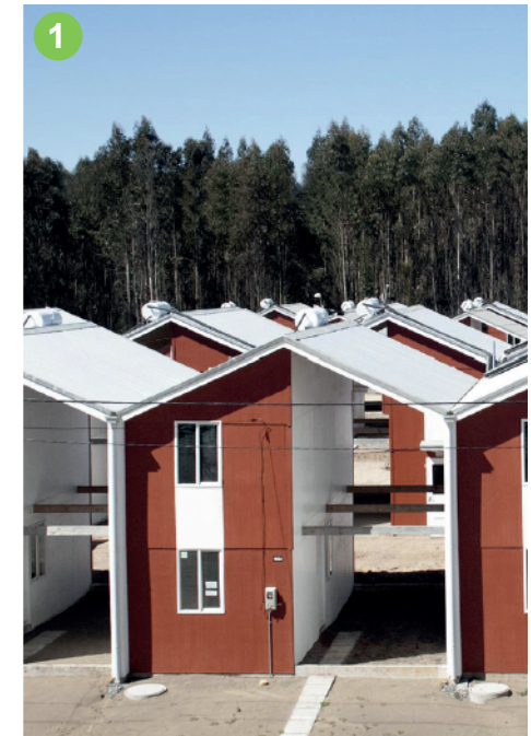
Fig.2.2: : Habitação Villa Verde Fonte: ArchDaily
