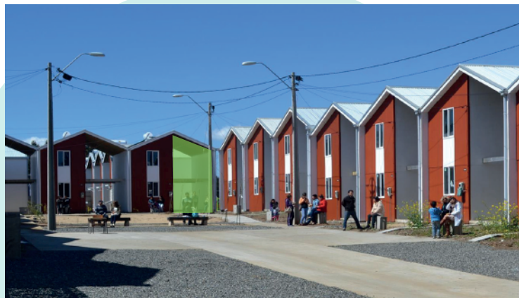
Fig.2.5 : Habitação Villa Verde Fonte: ArchDaily
