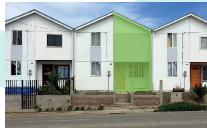
Fig.2.7 : Habitação Villa Verde Fonte: ArchDaily
