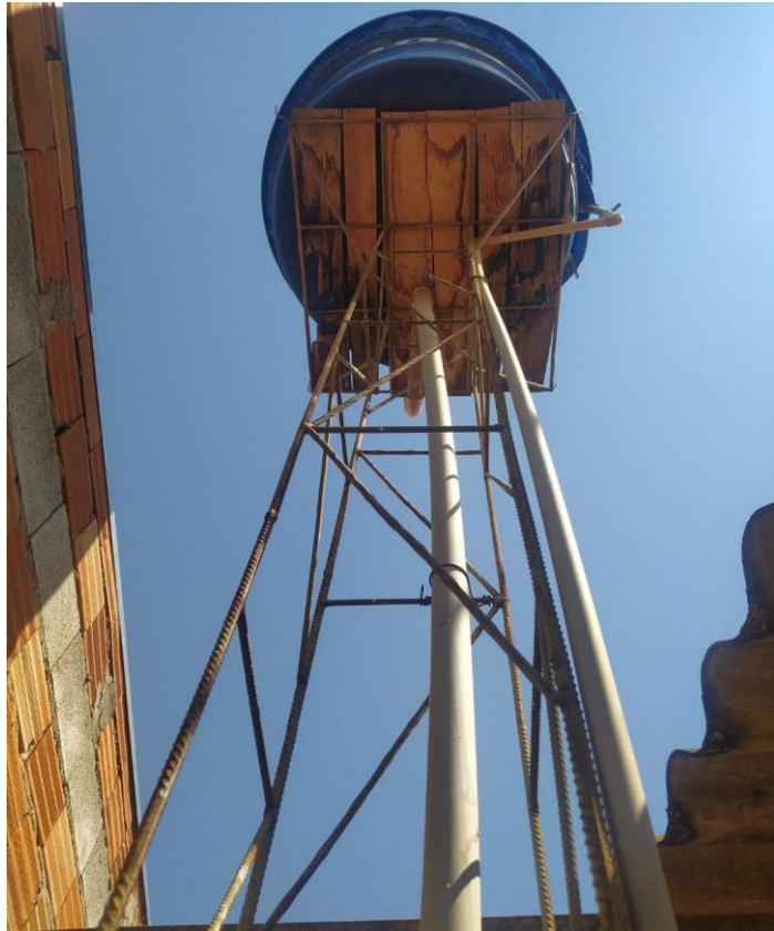
Figura 7: Vista inferior de uma caixa d'água
