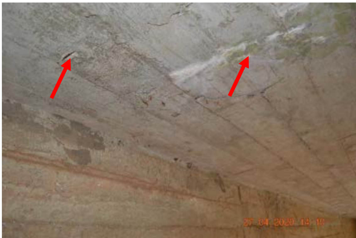
Identificação: Fotografia 6 – Lixiviação, exposição e corrosão das armaduras com pequena perda de área de aço devido o pequeno cobrimento das armaduras.
