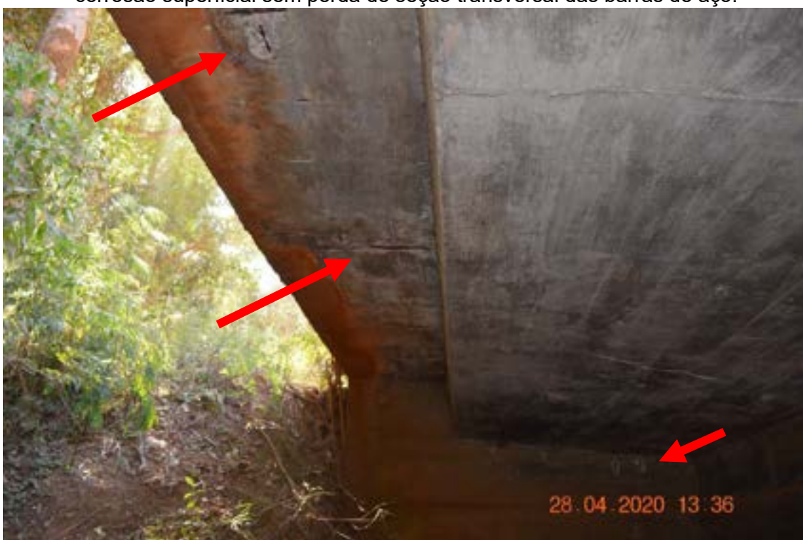
Identificação: Fotografia 3 – Lixiviação devido a ausência de pingadeira com exposição de armadura e corrosão superficial sem perda de seção transversal das barras de aço.
