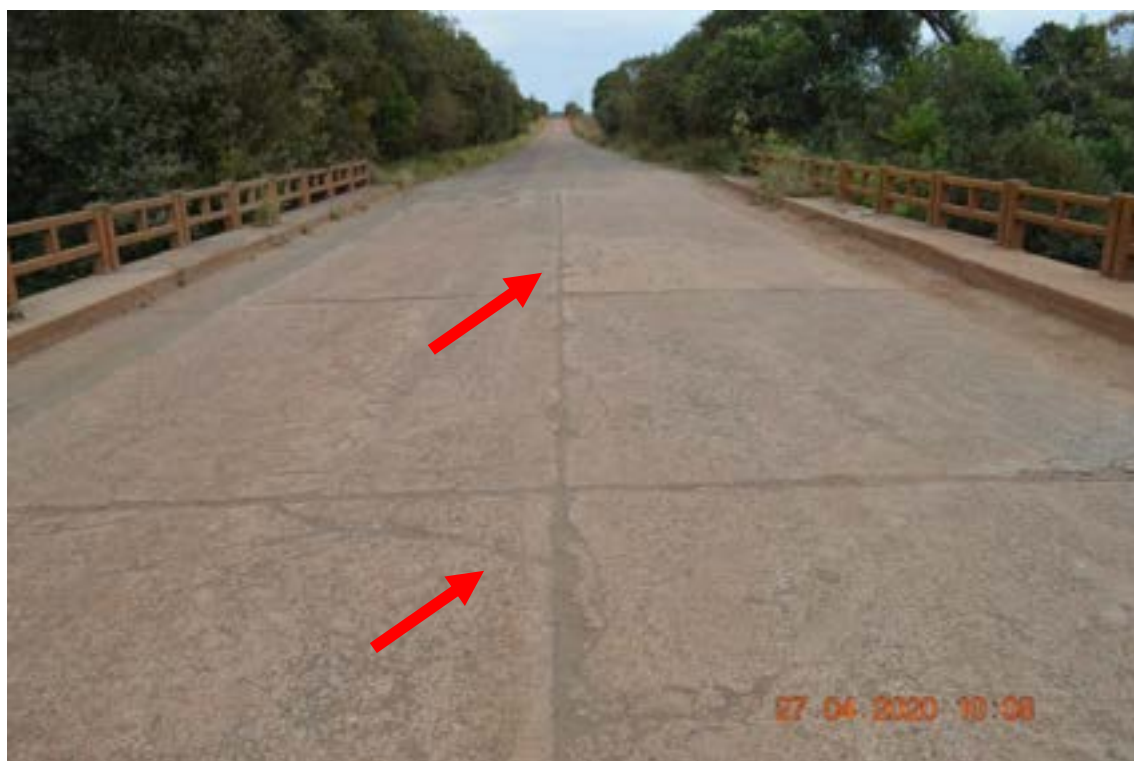
Identificação: Fotografia 12 – Abrasão e fissuração no pavimento em concreto.
