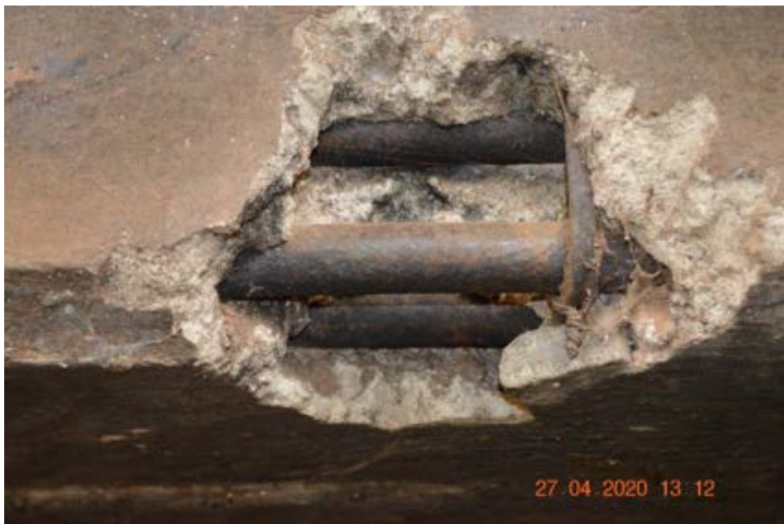
Identificação: Fotografia 14 – Exposição de armadura devido a falha na concretagem na longarina 2.
