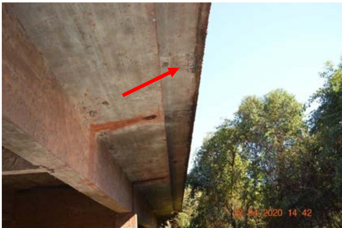
Identificação: Fotografia 8 – Lixiviação devido a ausência de pingadeira com exposição de armadura e corrosão superficial sem perda de seção transversal das barras de aço.
