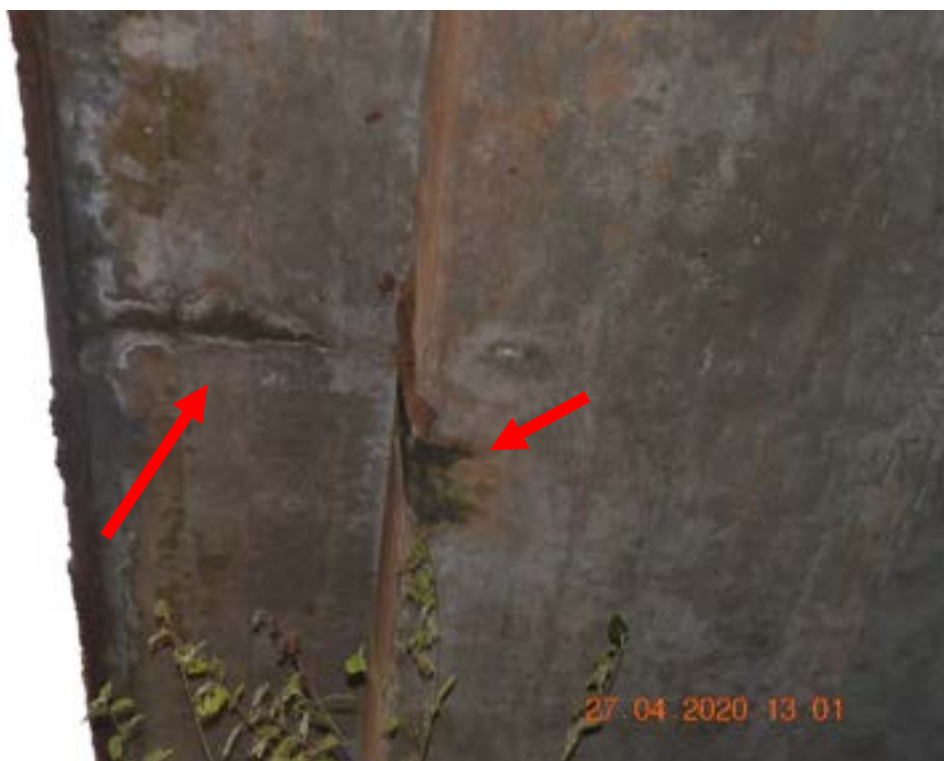
Identificação: Fotografia 8 – Lixiviação superficial no concreto.
