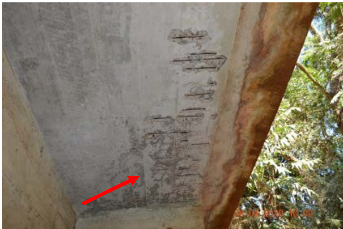
Identificação: Fotografia 8 – Adensamento excessivo no encontro da OAE.
