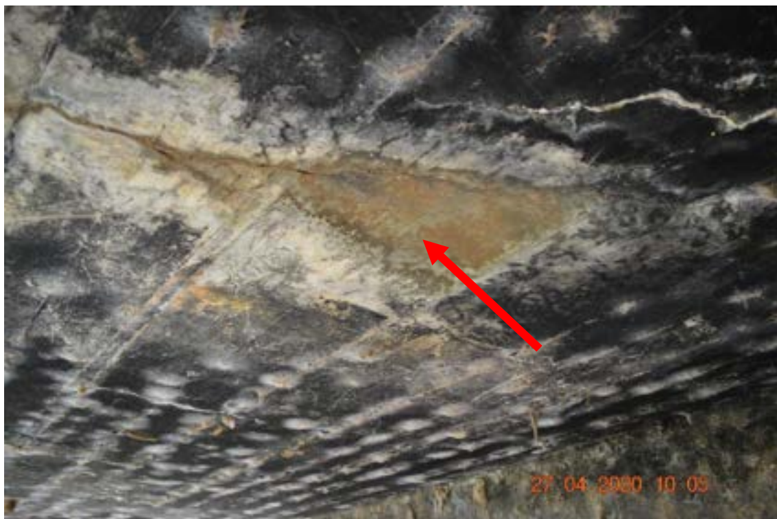
Identificação: Fotografia 10 – Lixiviação, exposição e corrosão das armaduras com pequena perda de área de aço devido ao pequeno cobrimento das armaduras.
