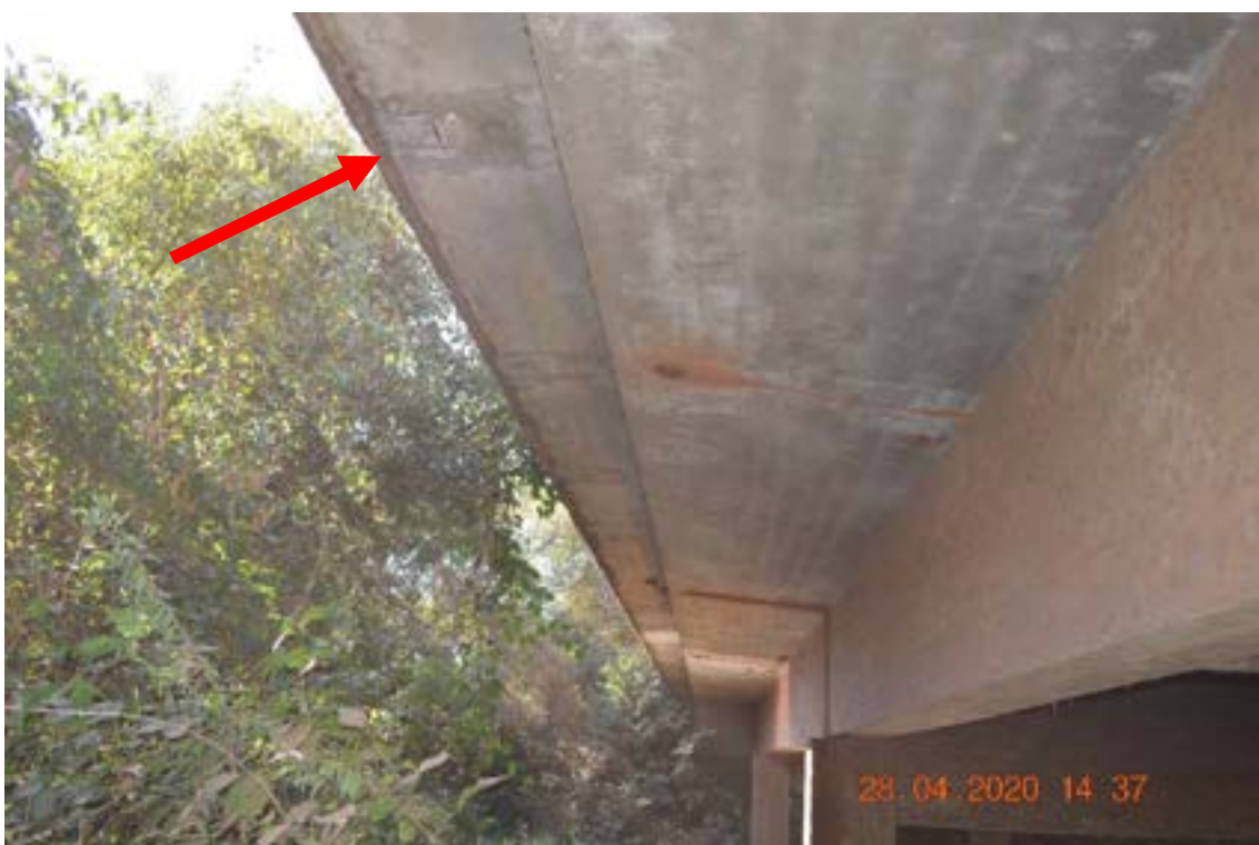
Identificação: Fotografia 4 – Lixiviação devido a ausência de pingadeira com exposição de armadura e corrosão superficial sem perda de seção transversal das barras de aço. Início de lixiviação devido o pequeno comprimento do buzinode.
