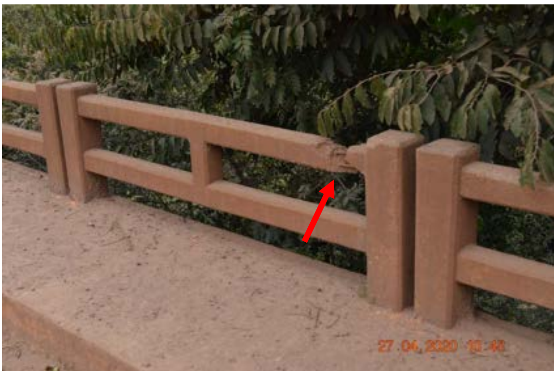
Identificação: Fotografia 6 – Guarda-corpo danificado por provável impacto.
