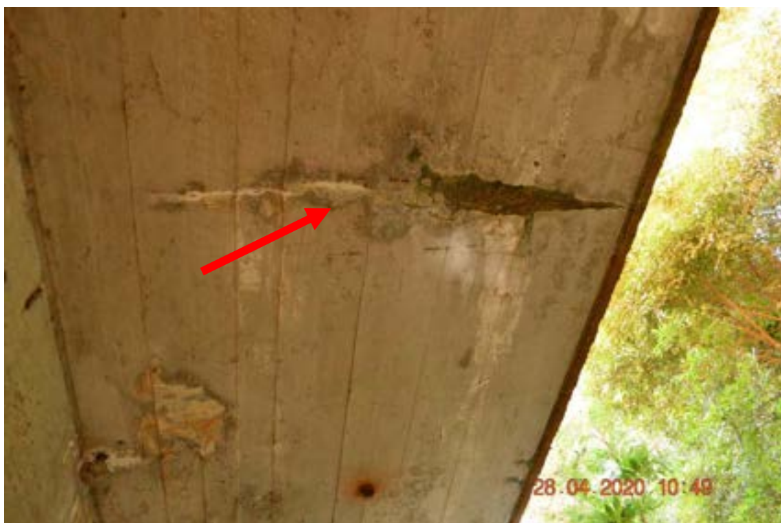
Identificação: Fotografia 8 – Esmagamento do concreto do pavimento.
