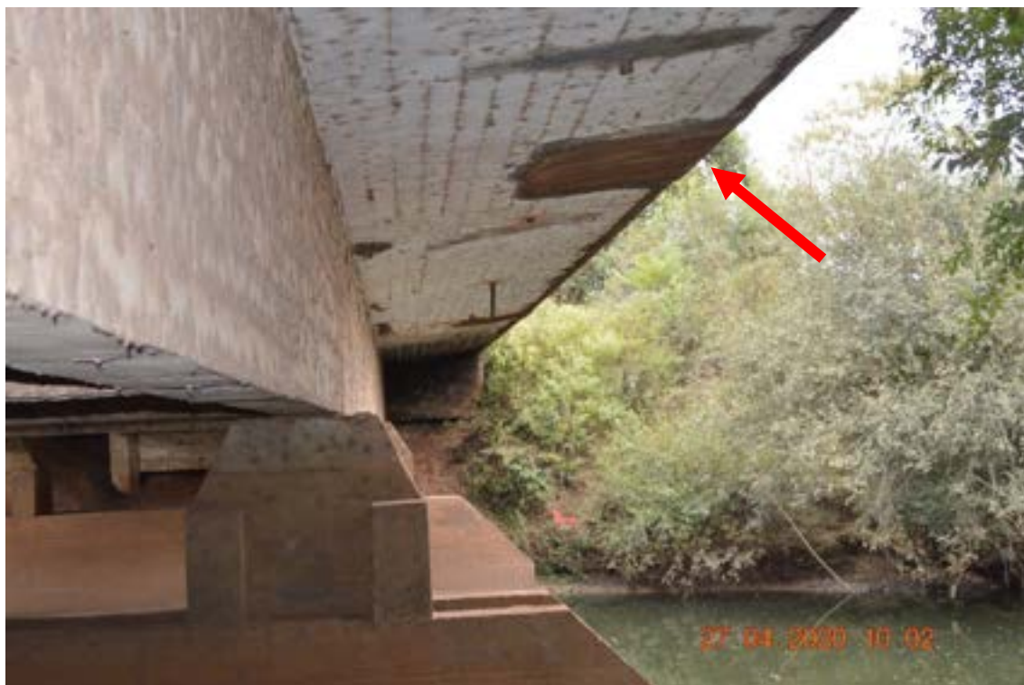
Identificação: Fotografia 6 – Exposição de armadura (estribo) com corrosão superficial devido ao pequeno cobrimento das armaduras.
