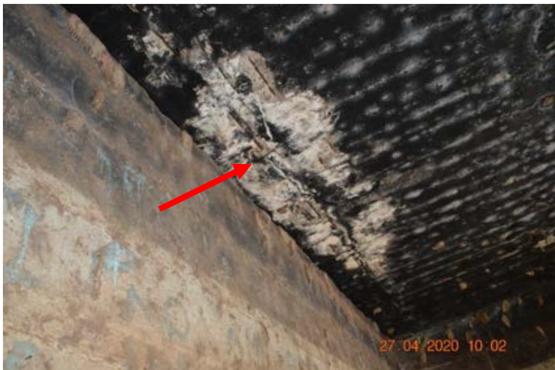
Identificação: Fotografia 8 – Lixiviação na região de microfissuras no tabuleiro.
