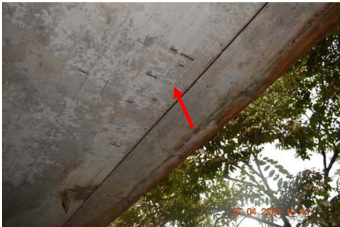
Identificação: Fotografia 4 – Exposição e corrosão das armaduras com pequena perda de área de aço devido o pequeno cobrimento das armaduras.
