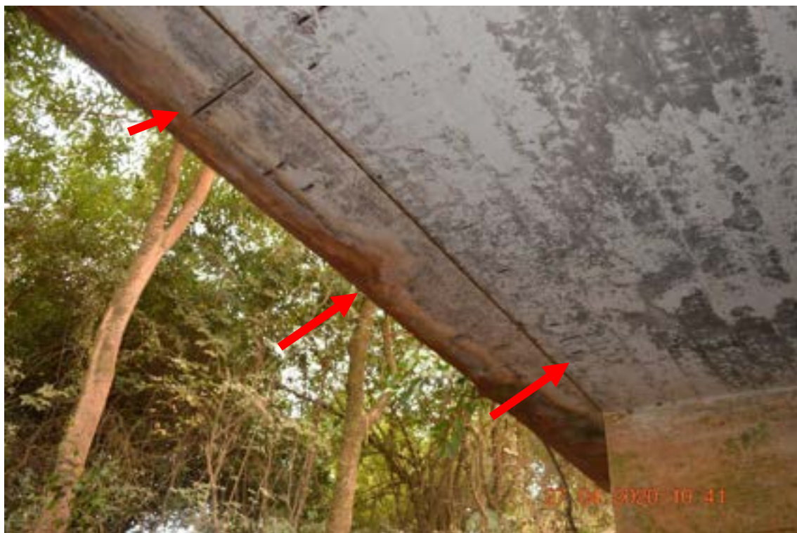
Identificação: Fotografia 4 – Exposição e corrosão das armaduras com pequena perda de área de aço devido o pequeno cobrimento das armaduras.
