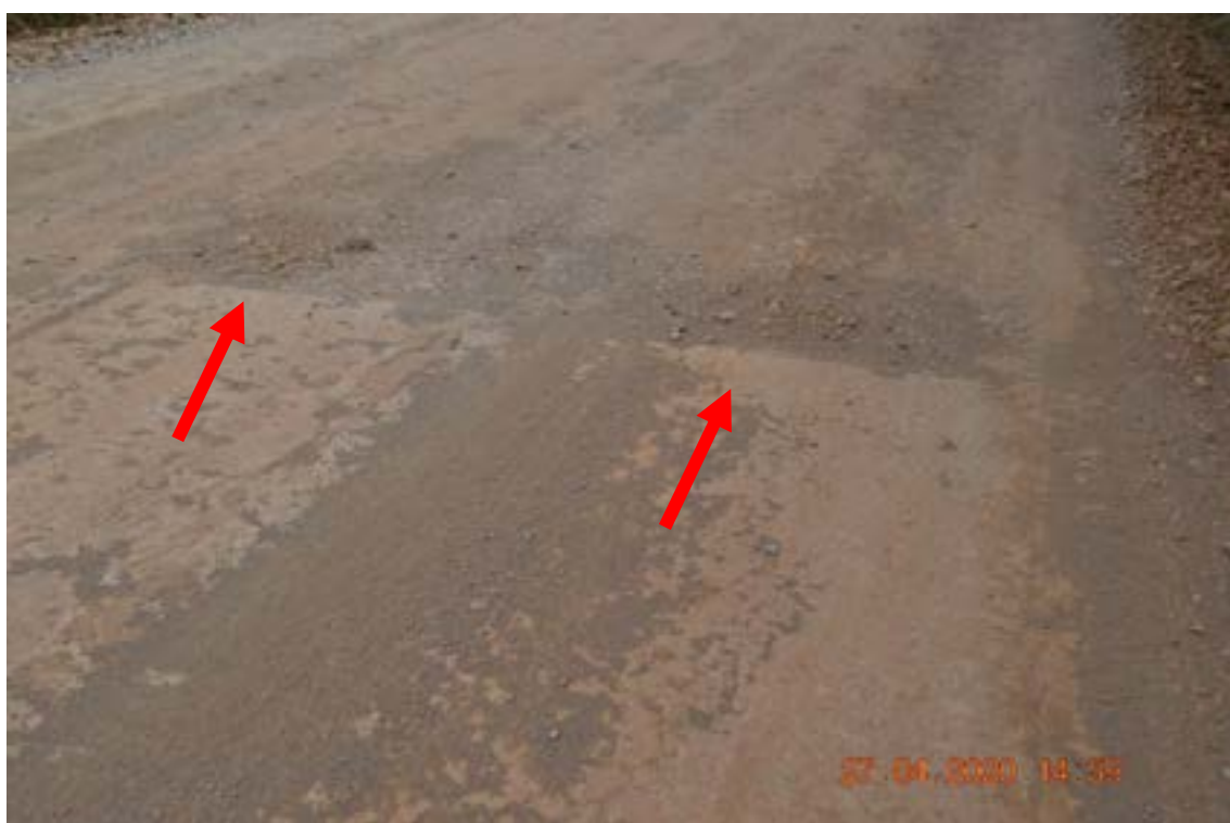
Identificação: Fotografia 6 – Adensamento expressivo na região dos encontros da OAE.
