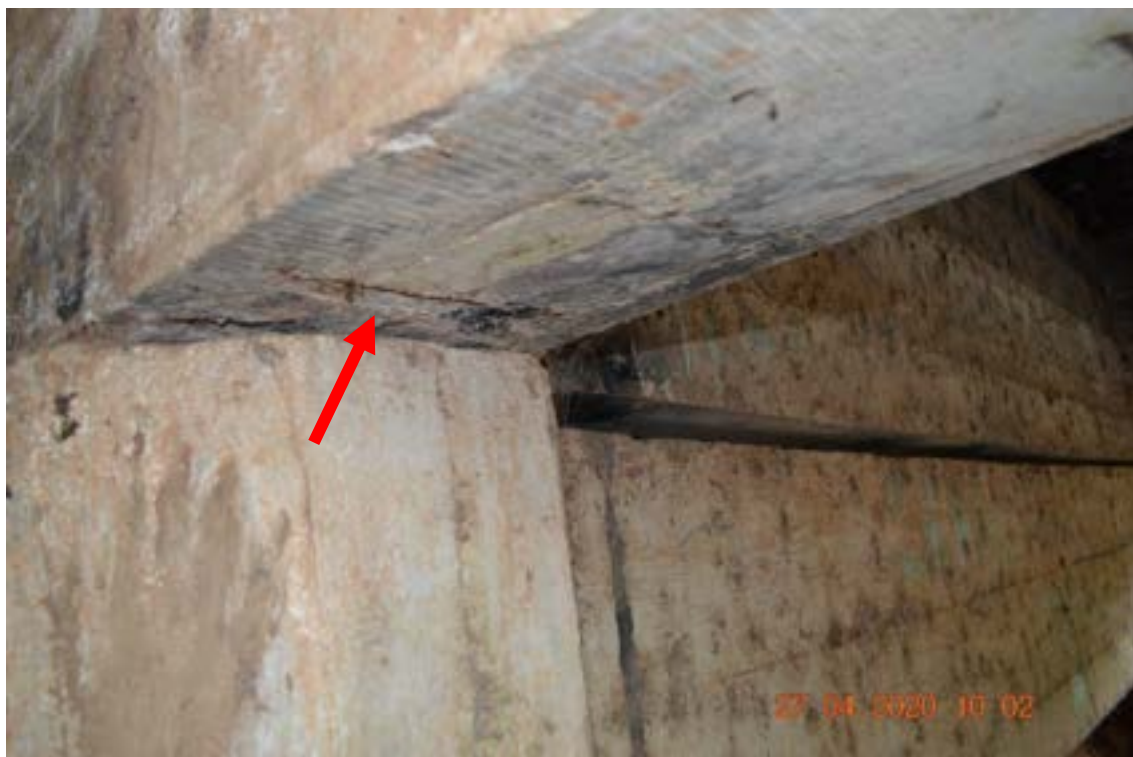
Identificação: Fotografia 6 – Exposição de armadura (estribo) com corrosão superficial devido ao pequeno cobrimento das armaduras.
