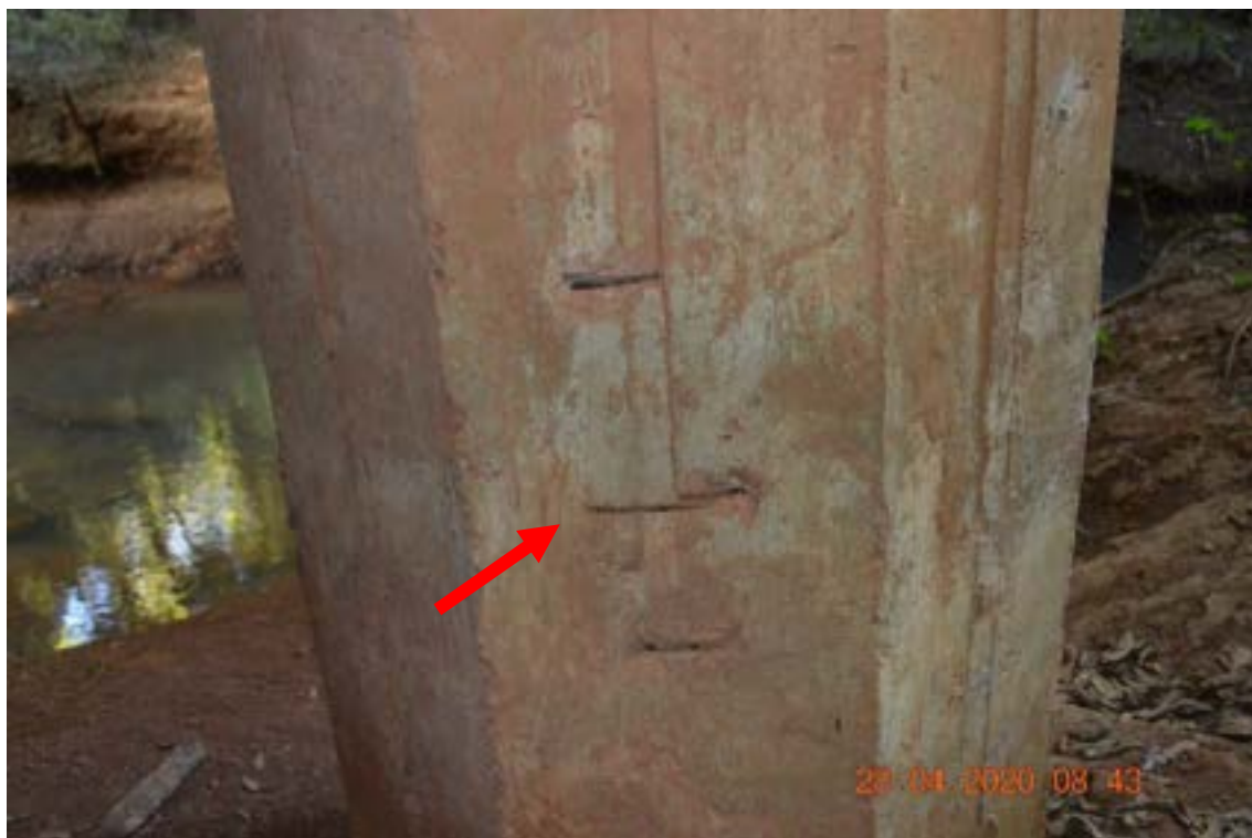
Identificação: Fotografia 6 – Falha de concretagem com armadura exposta com corrosão superficial sem perda de área de aço.
