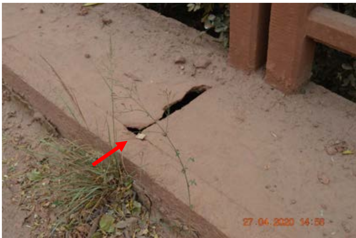
Identificação: Fotografia 4 – Placa na região do guarda-rodas com ruptura localizada.
