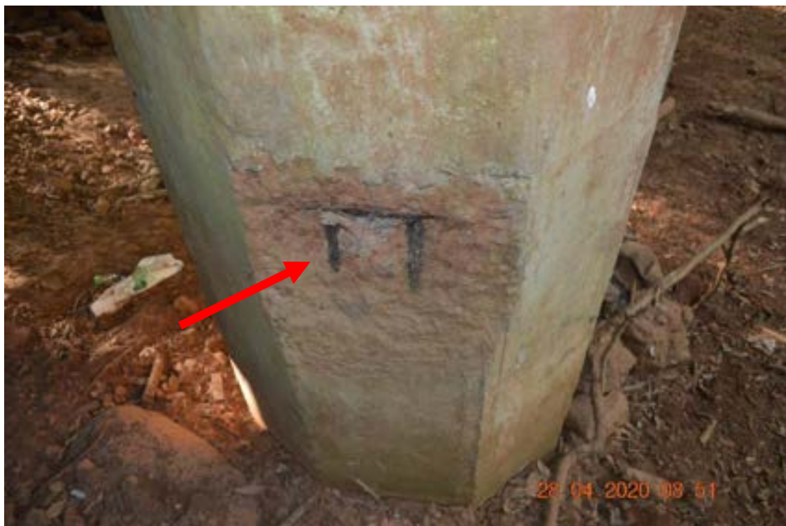
Identificação: Fotografia 8 – Falha de concretagem com exposição das armaduras com corrosão destas com baixa perda de seção de aço. Pilar P5.
