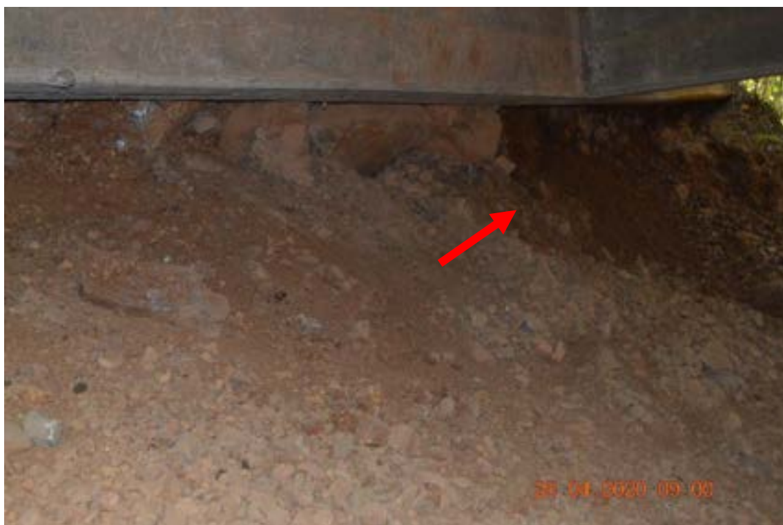
Identificação: Fotografia 10 – Perda o maciço de solo na região das cortinas.
