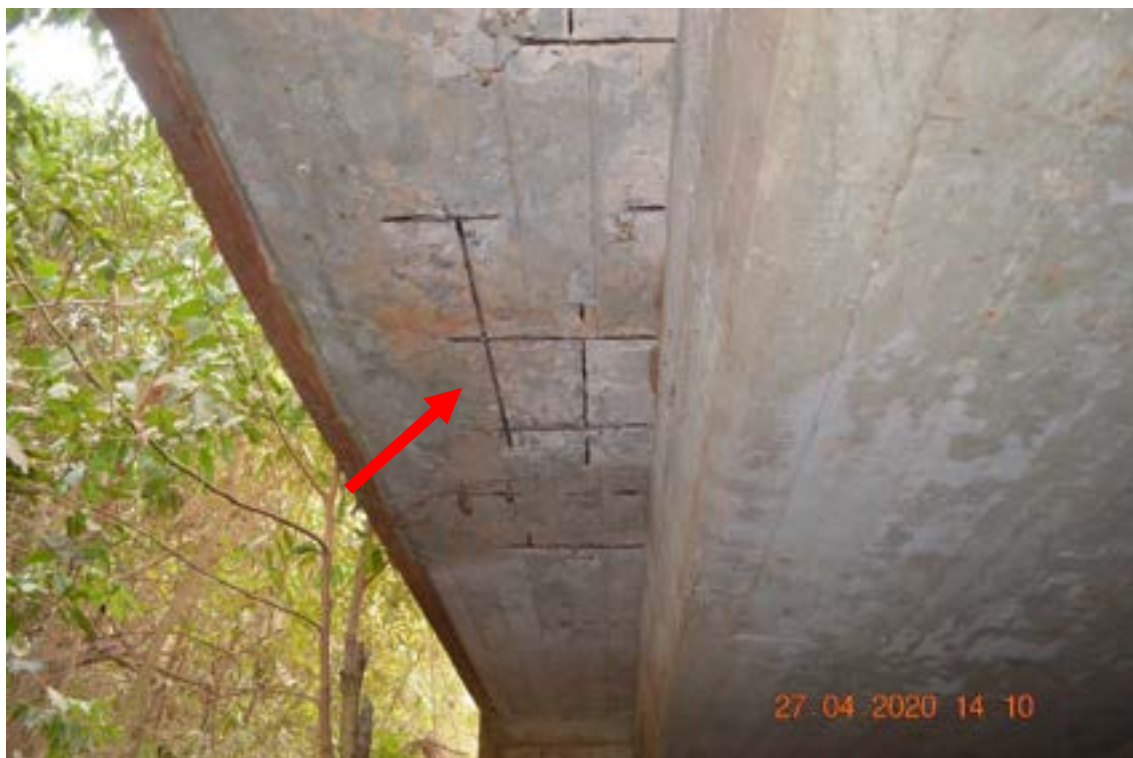
Identificação: Fotografia 6 – Lixiviação, exposição e corrosão das armaduras com pequena perda de área de aço devido o pequeno cobrimento das armaduras.
