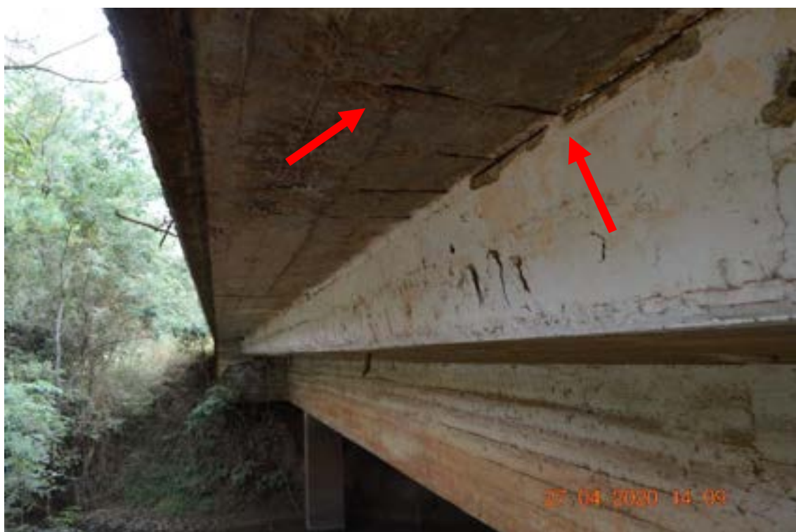
Identificação: Fotografia 4 – Exposição e corrosão das armaduras com pequena perda de área de aço devido a lixiviação e o pequeno cobrimento das armaduras.
