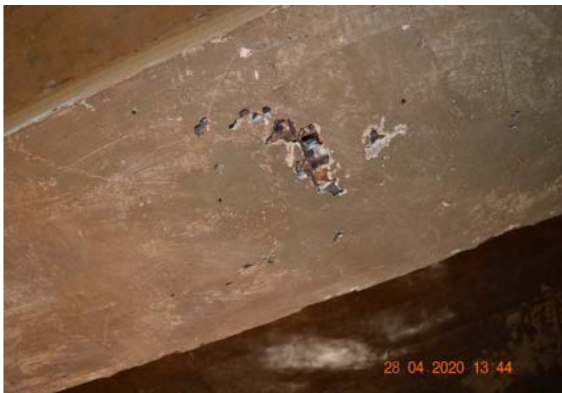
Identificação: Fotografia 13 – Armadura exposta devida a falha de concretagem, sem evidências de corrosão de armaduras.
