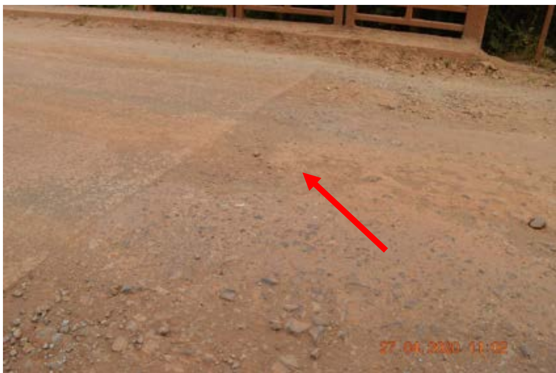
Identificação: Fotografia 10 – Adensamento excessivo nos encontros.
