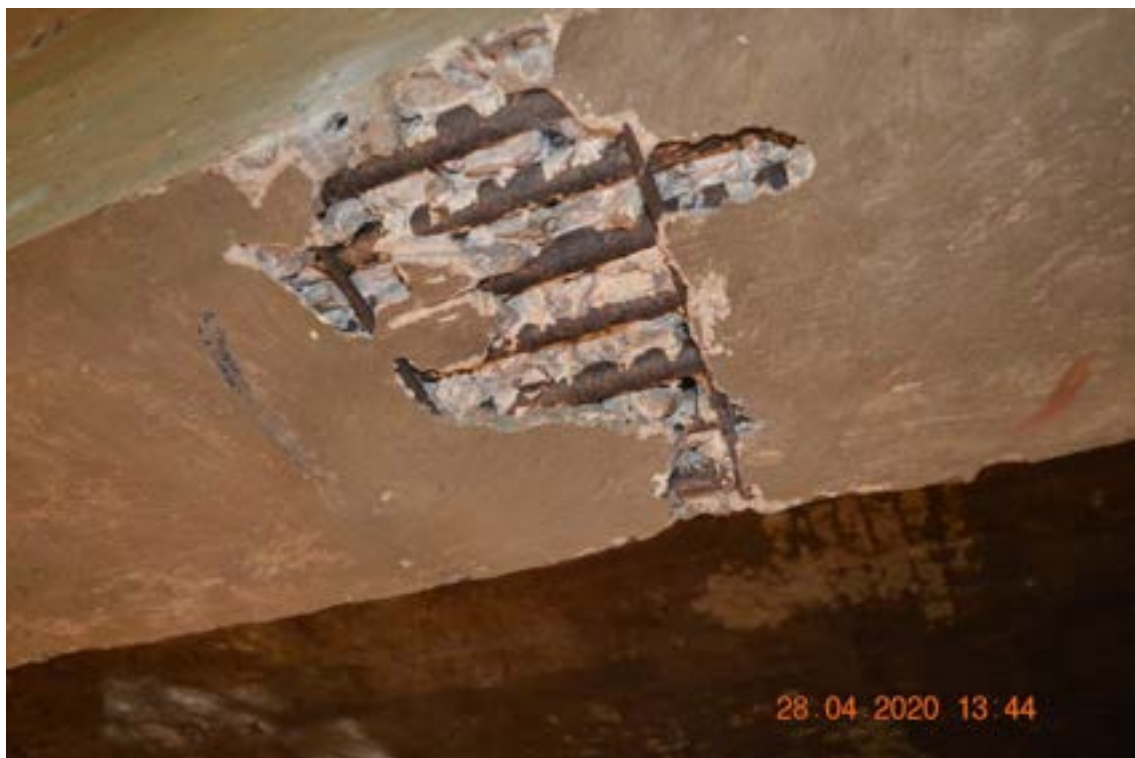
Identificação: Fotografia 13 – Armadura exposta devida a falha de concretagem, sem evidências de corrosão de armaduras.
