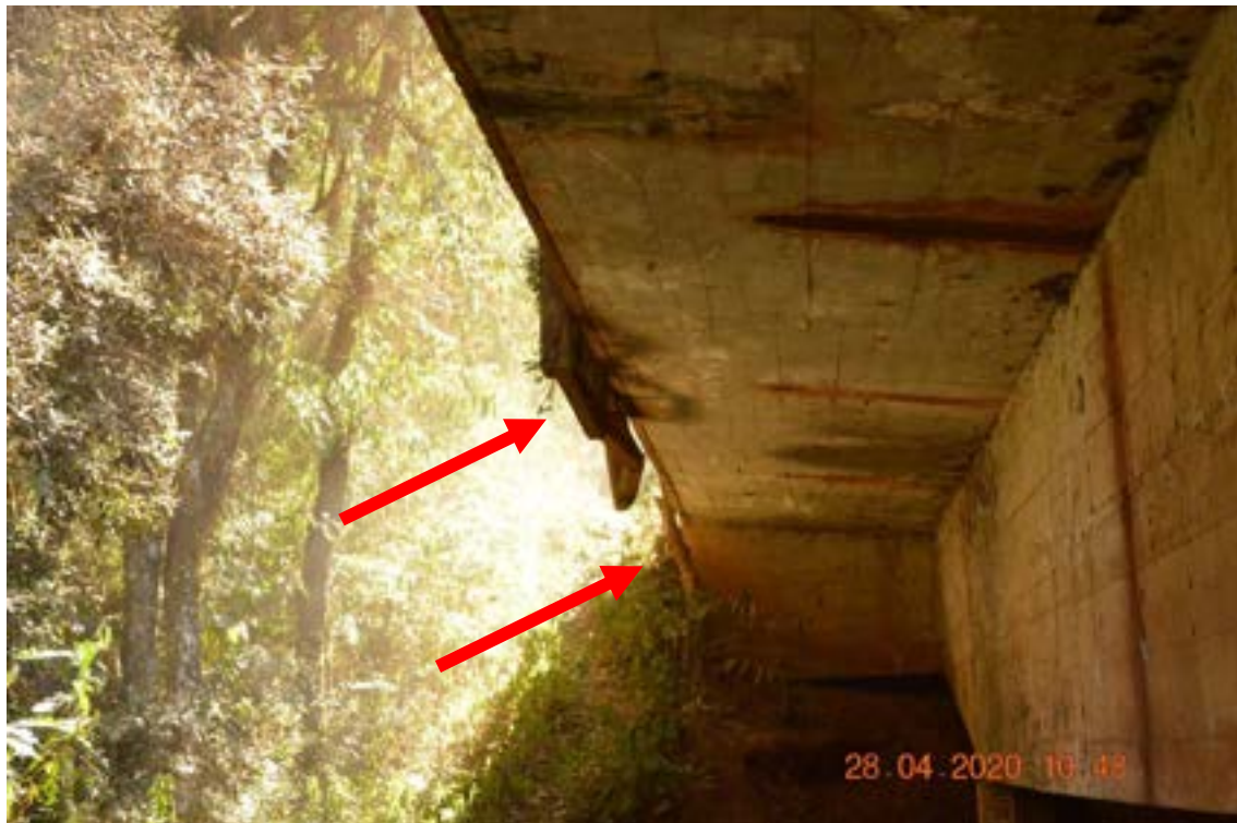
Identificação: Fotografia 6 – Fissura na laje com lixiviação sem evidências de corrosão das armaduras.
