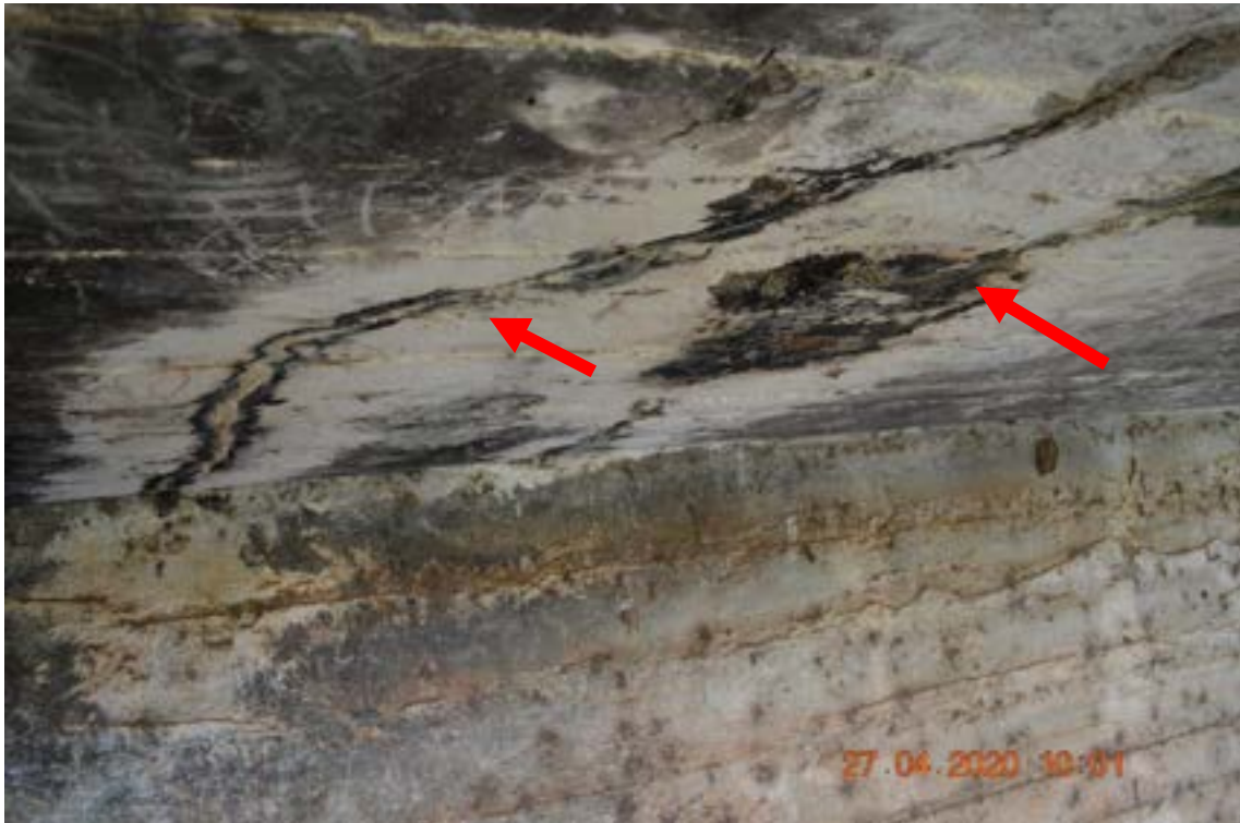
Identificação: Fotografia 4 – Lixiviação na região de microfissuras no tabuleiro.
