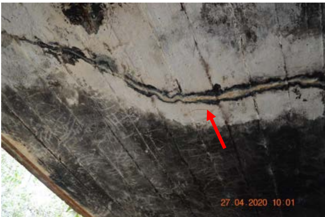
Identificação: Fotografia 4 – Lixiviação na região de microfissuras no tabuleiro.
