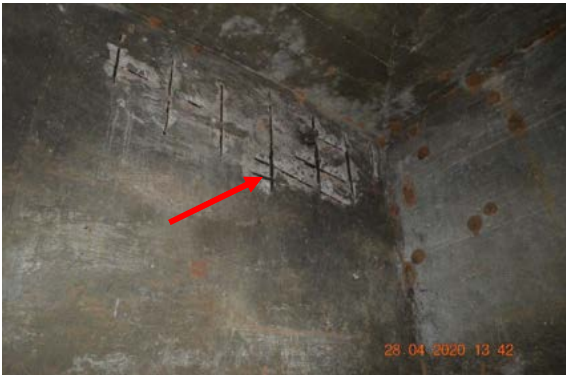
Identificação: Fotografia 9 – Exposição de armadura de costela e corrosão superficial sem perda de seção transversal das barras de aço devido ao baixo cobrimento das armaduras.
