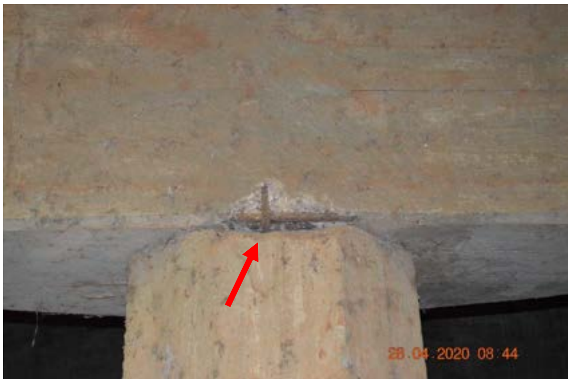
Identificação: Fotografia 6 – Falha de concretagem com armadura exposta com corrosão superficial sem perda de área de aço.
