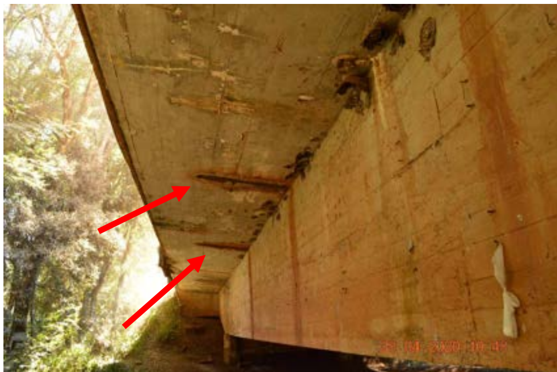
Identificação: Fotografia 4 – Início de lixiviação devido o pequeno comprimento do buzinode.
