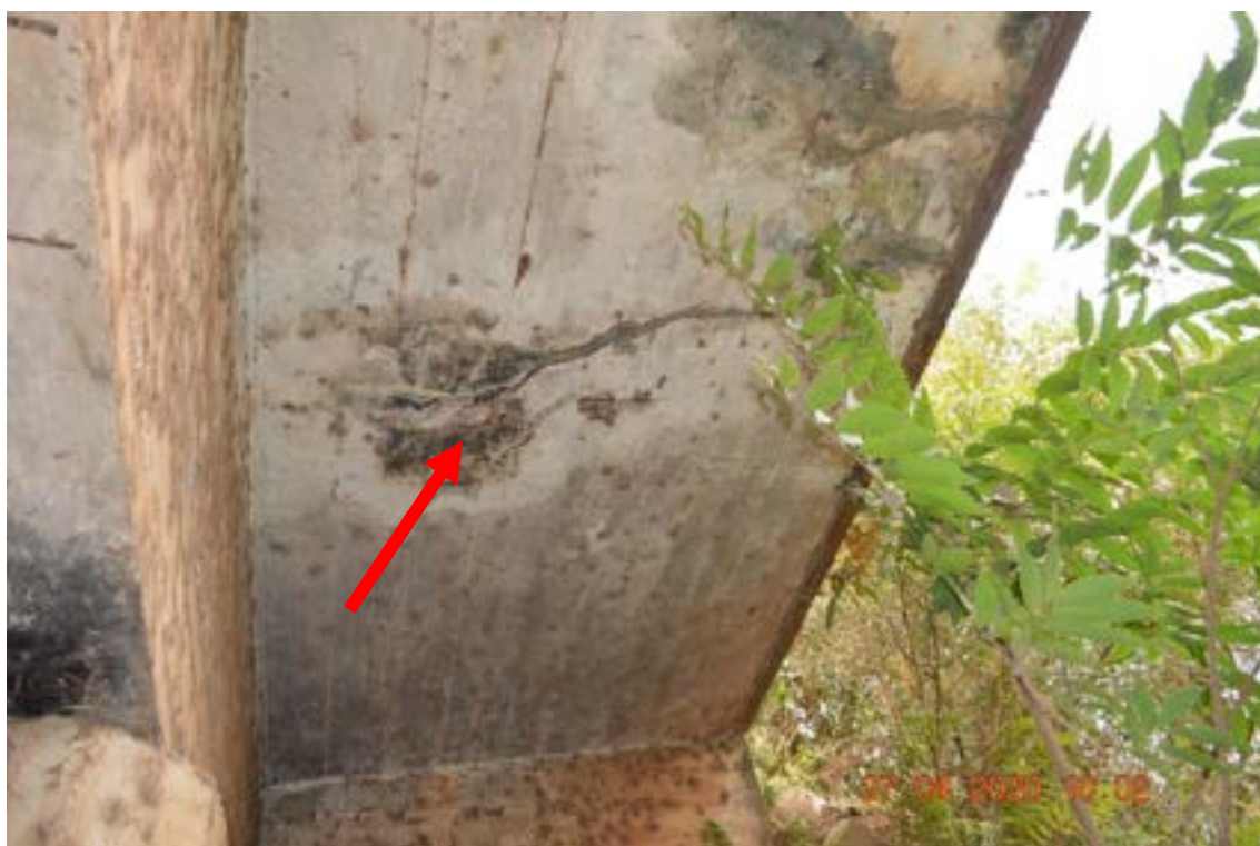
Identificação: Fotografia 8 – Lixiviação na região de microfissuras no tabuleiro.
