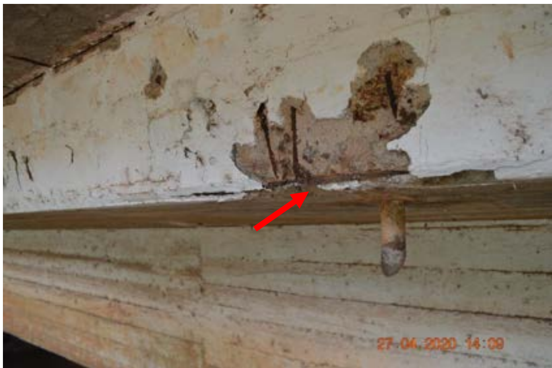
Identificação: Fotografia 4 – Exposição e corrosão das armaduras com pequena perda de área de aço devido a lixiviação e o pequeno cobrimento das armaduras.
