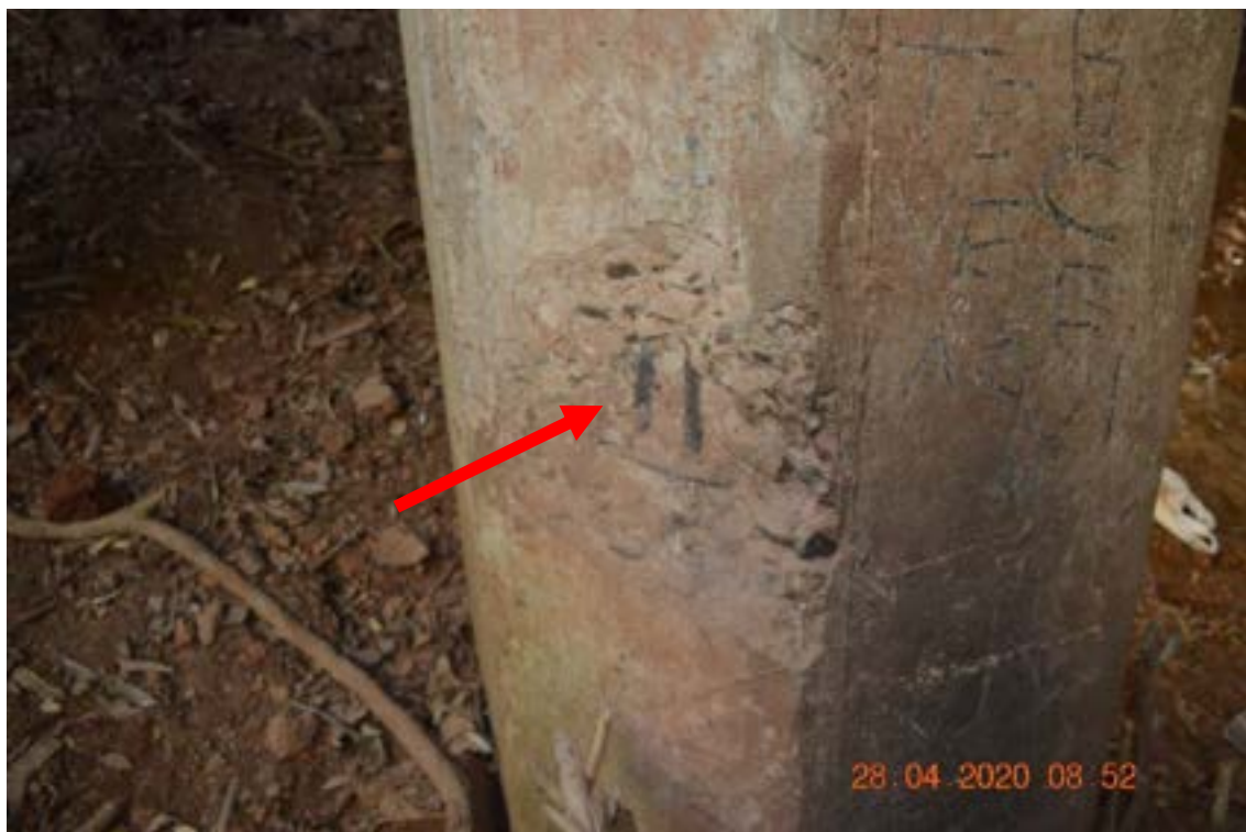
Identificação: Fotografia 8 – Falha de concretagem com exposição das armaduras com corrosão destas com baixa perda de seção de aço. Pilar P5.
