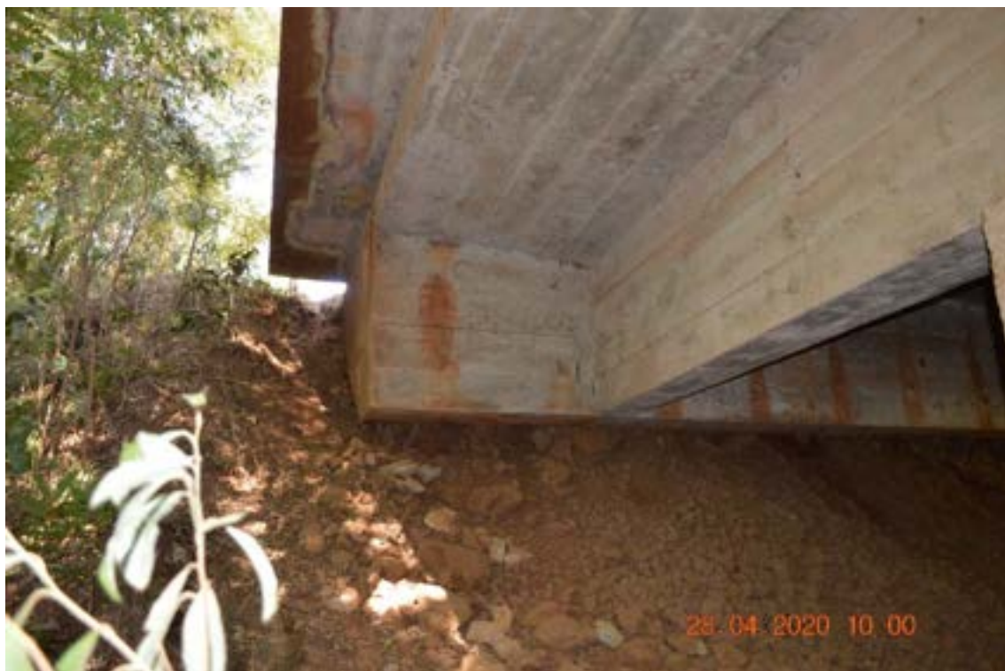
Identificação: Fotografia 6 – Armadura exposta com corrosão superficial e sem perda de área de aço.
