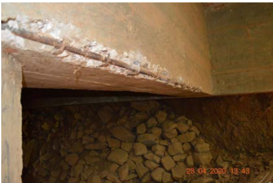
Identificação: Fotografia 11 – Armadura exposta devida a falha de concretagem, sem evidências de corrosão de armaduras.
