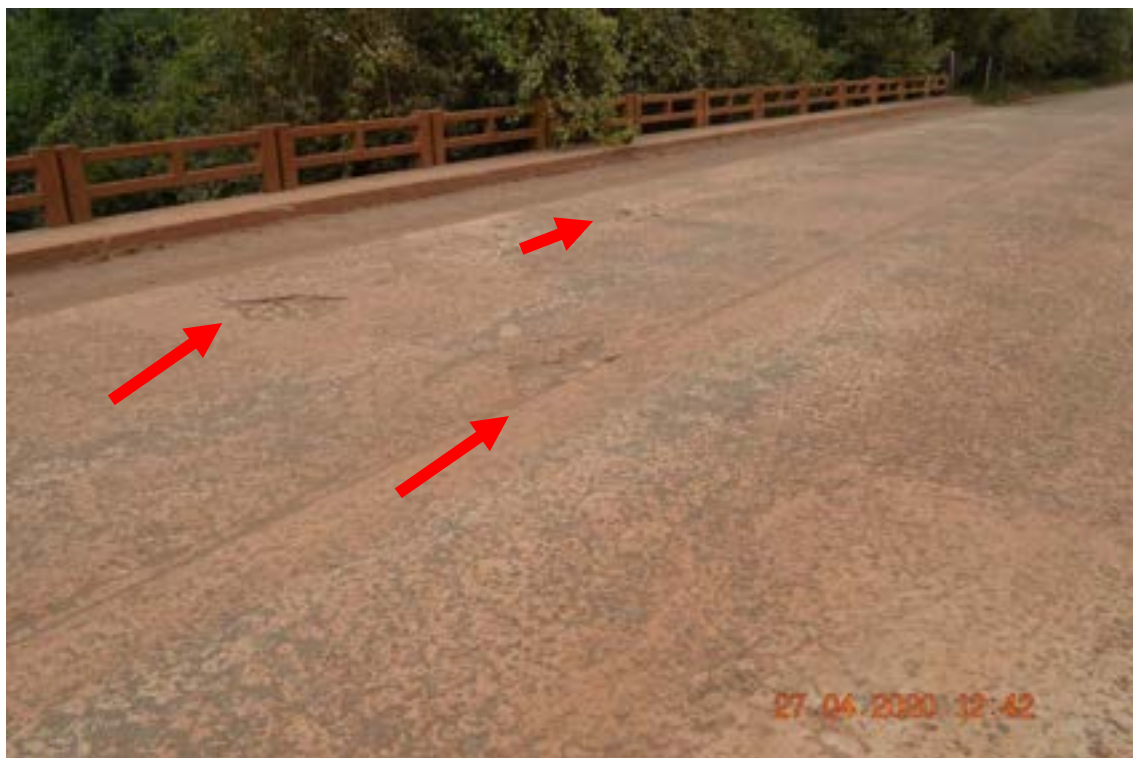
Identificação: Fotografia 4 – Lixiviação superficial no concreto.
