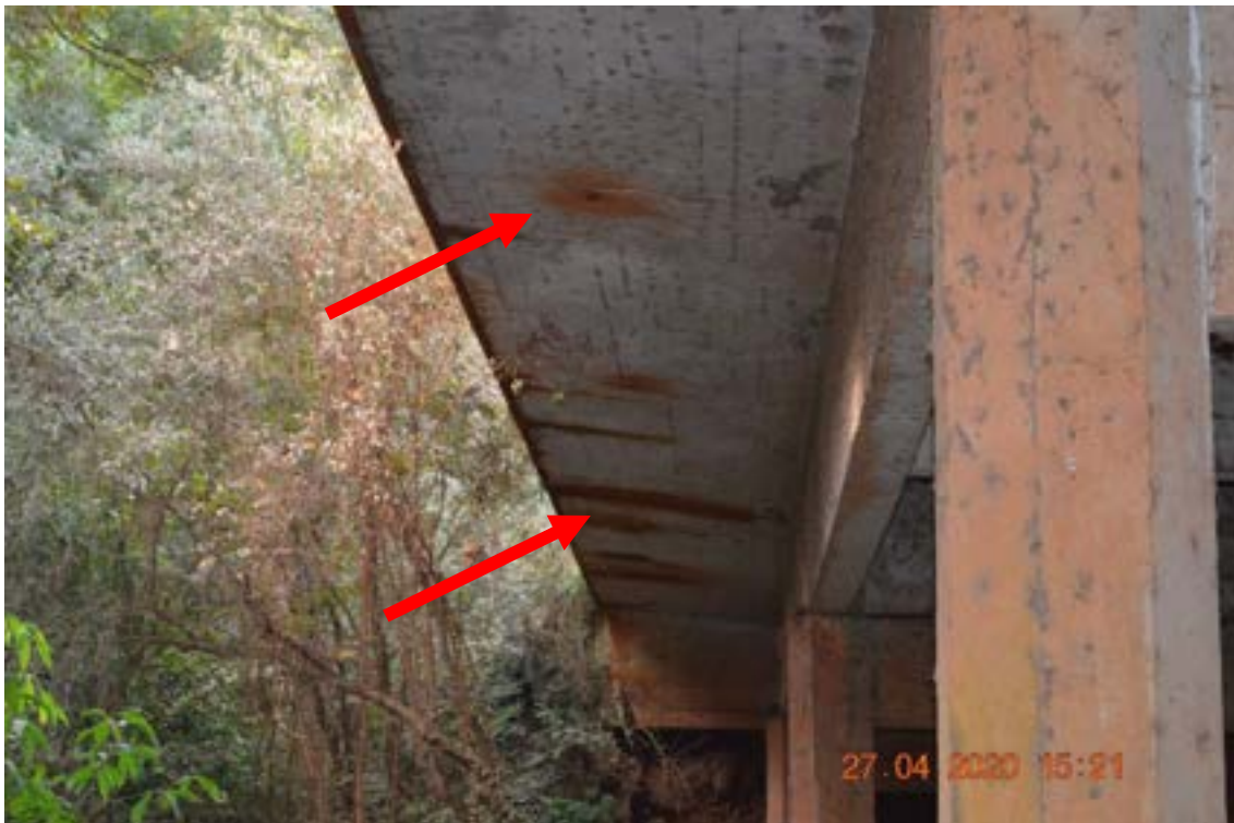
Identificação: Fotografia 10 – Lixiviação devido à ausência da tubulação do buzinode.
