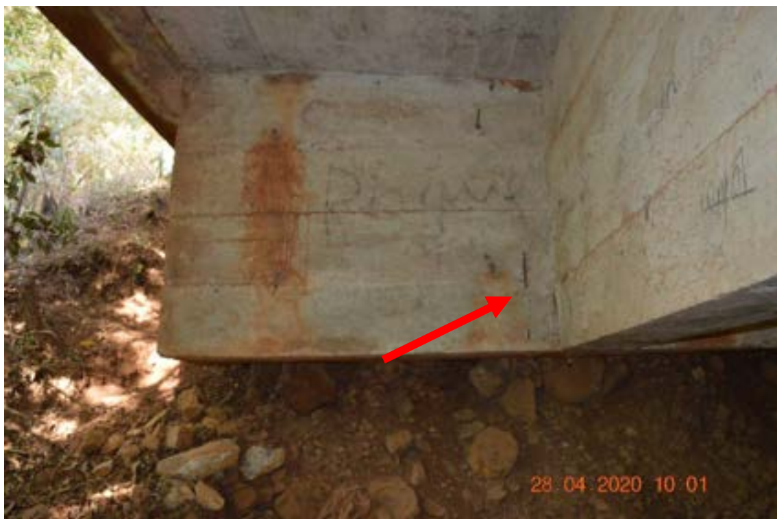
Identificação: Fotografia 6 – Armadura exposta com corrosão superficial e sem perda de área de aço.
