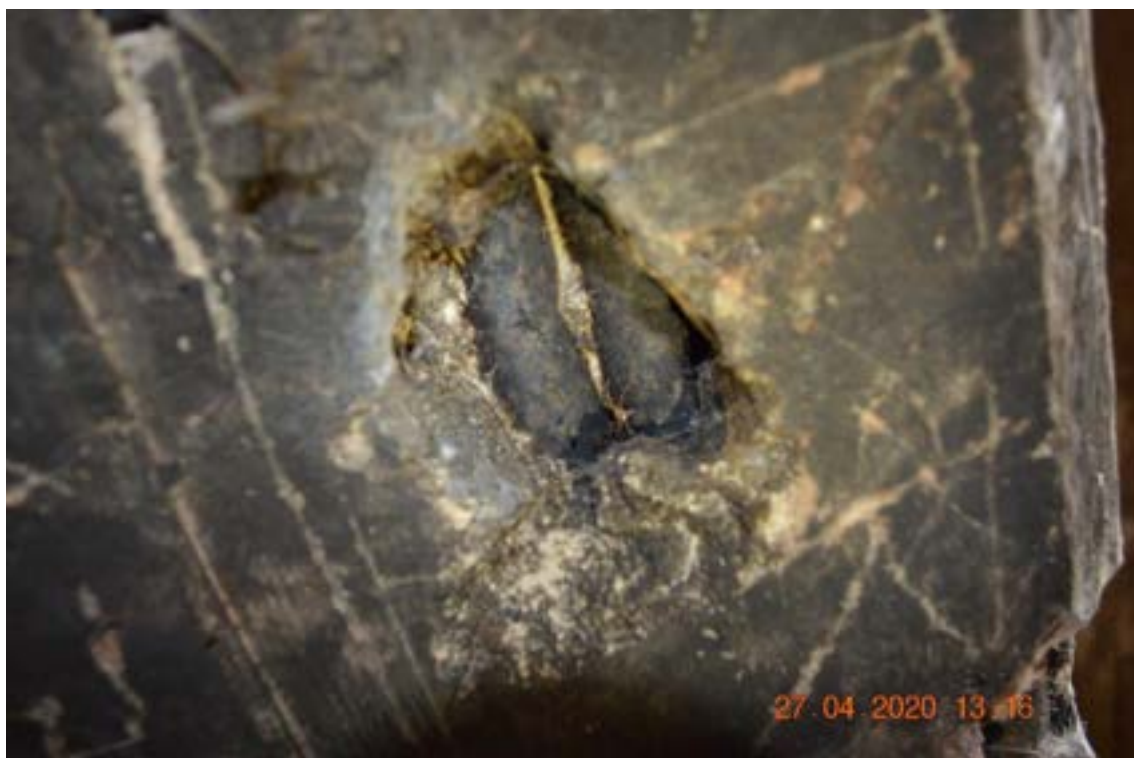
Identificação: Fotografia 14 – Exposição de armadura devido a falha na concretagem na longarina 2.
