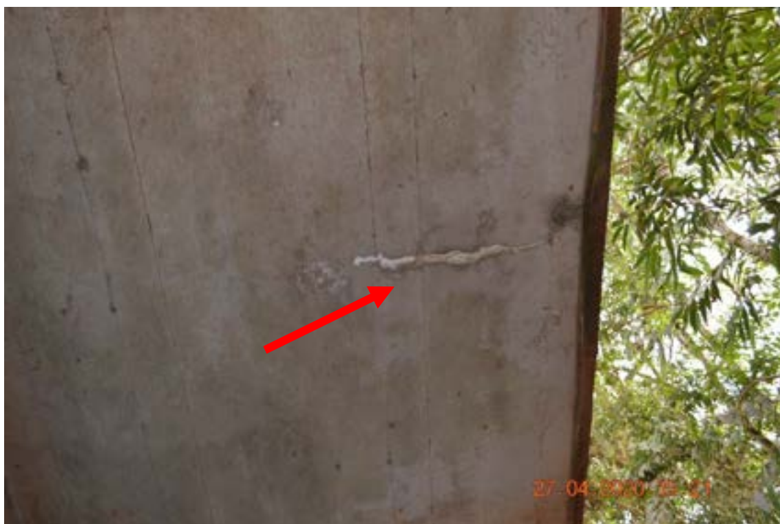
Identificação: Fotografia 8 – Lixiviação numa fissura localizada.
