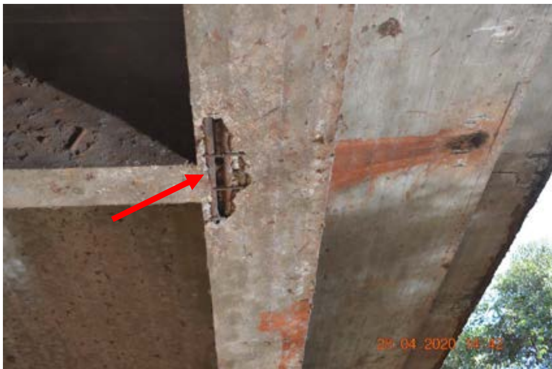
Identificação: Fotografia 8 – Lixiviação devido a ausência de pingadeira com exposição de armadura e corrosão superficial sem perda de seção transversal das barras de aço.
