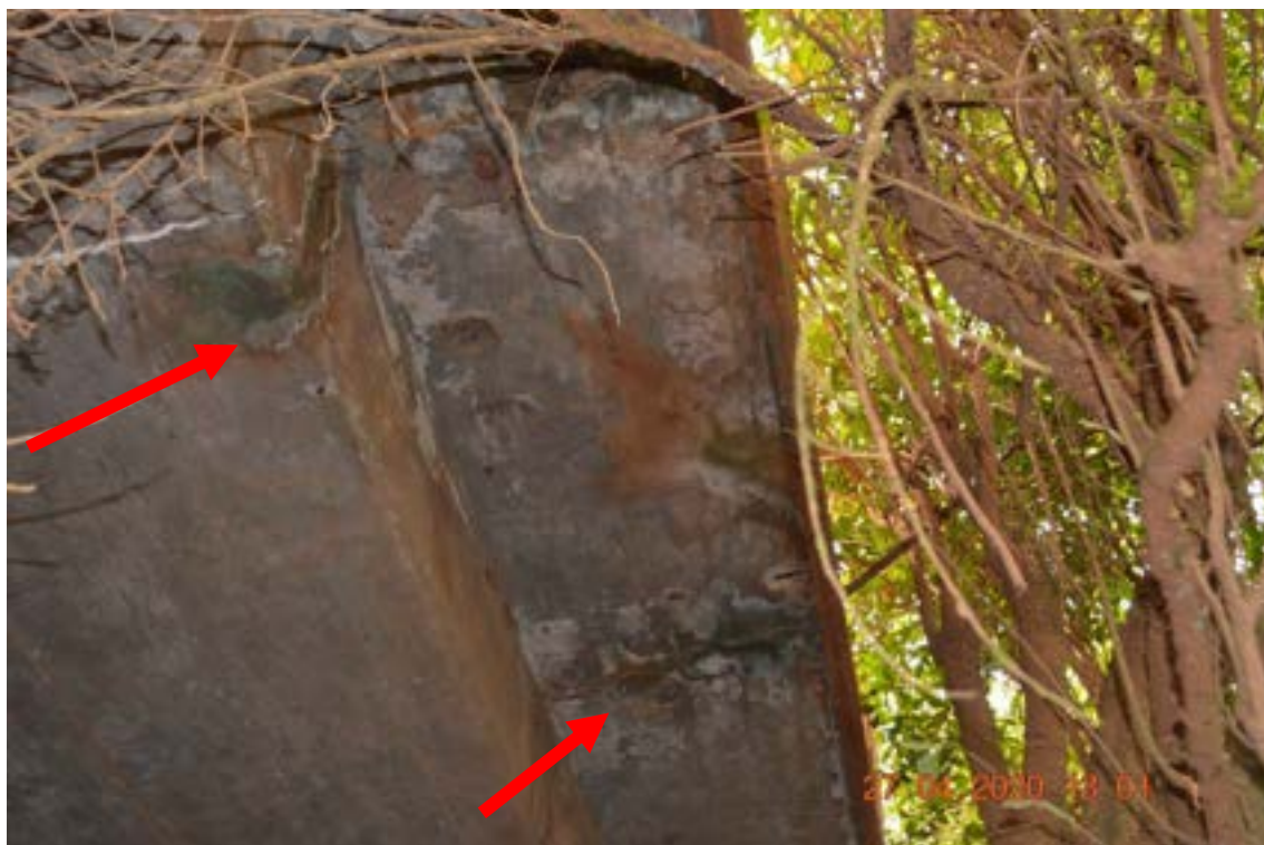
Identificação: Fotografia 8 – Lixiviação superficial no concreto.
