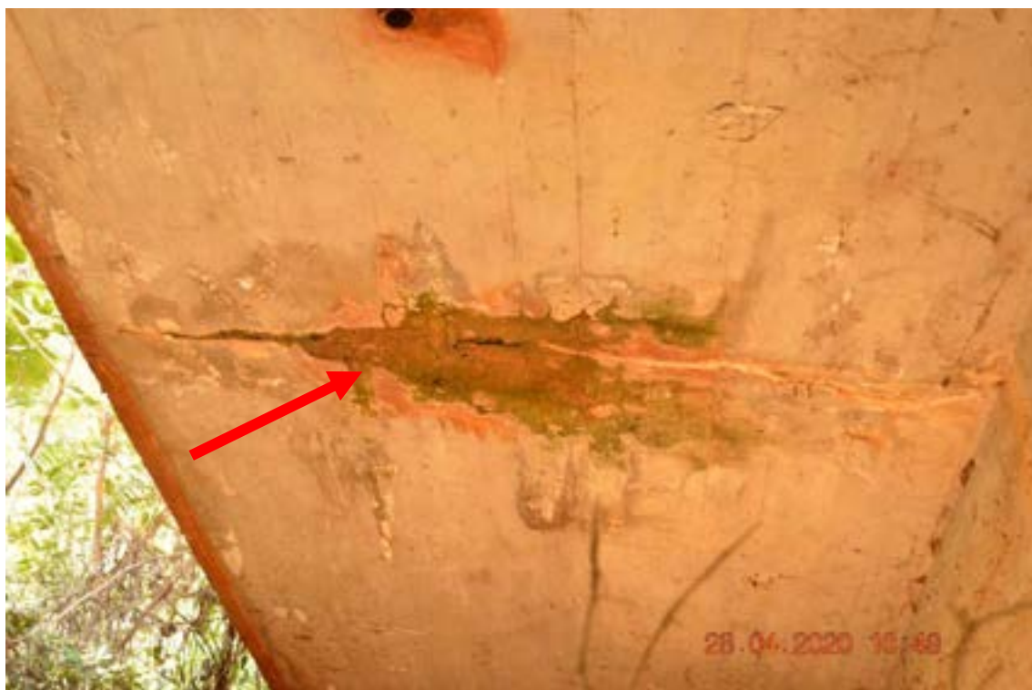
Identificação: Fotografia 6 – Fissura na laje com lixiviação sem evidências de corrosão das armaduras.
