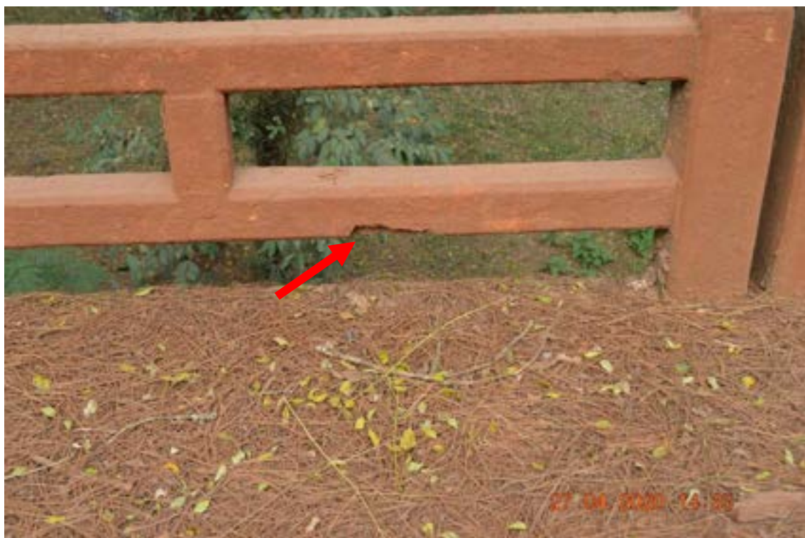
Identificação: Fotografia 10 – Armadura exposta devido a falha de concretagem do guarda-corpo..
