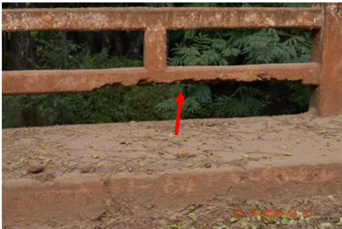
Identificação: Fotografia 10 – Armadura exposta devido a falha de concretagem do guarda-corpo..
