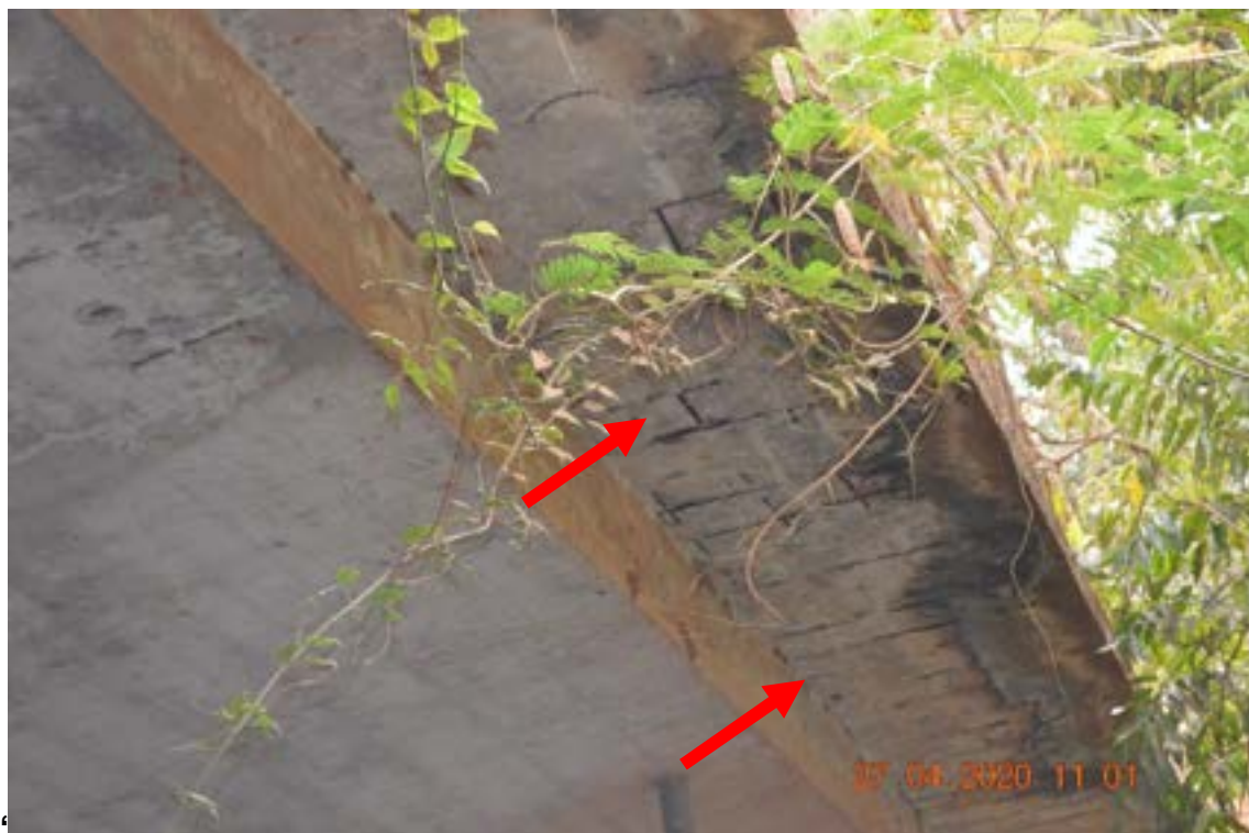
Identificação: Fotografia 10 – Adensamento excessivo nos encontros.
