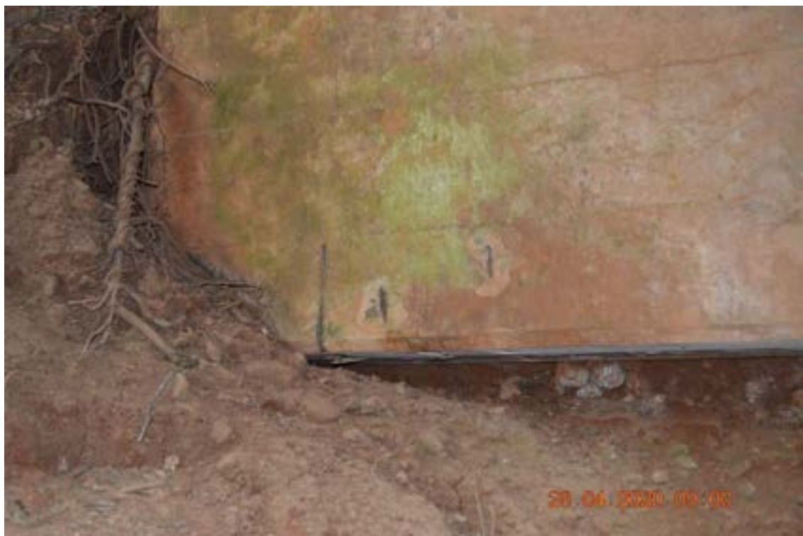
Identificação: Fotografia 10 – Perda o maciço de solo na região das cortinas.
