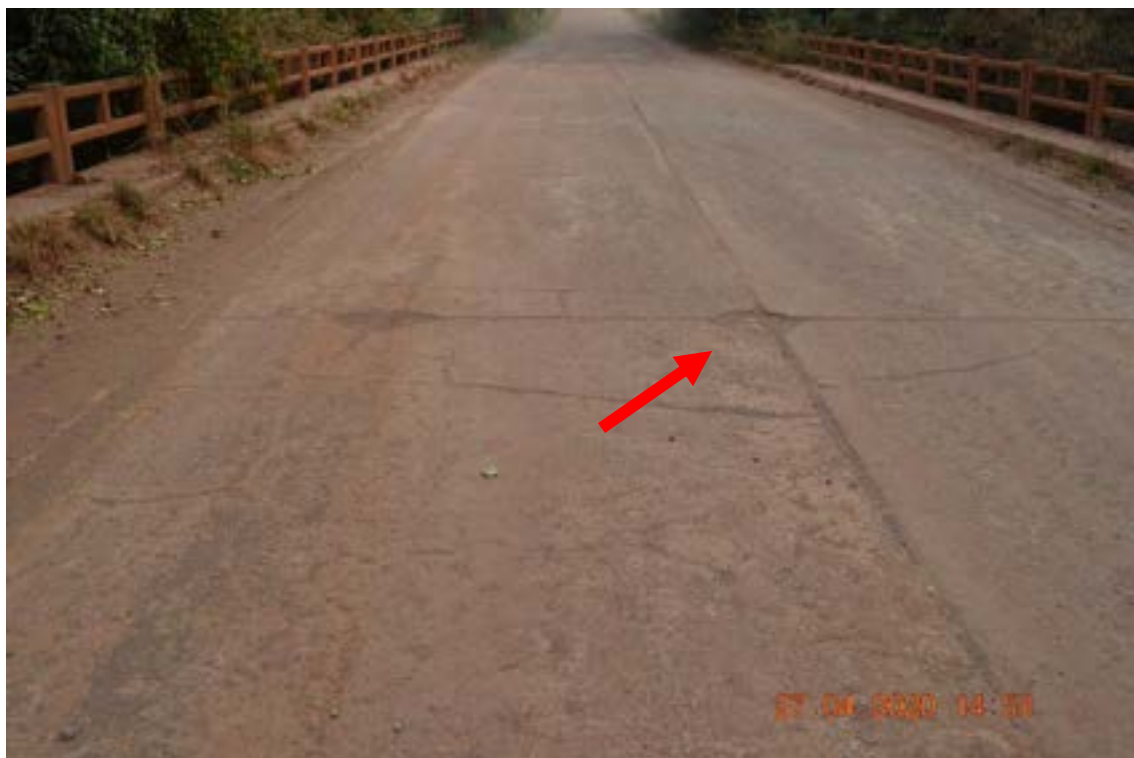
Identificação: Fotografia 4 – Placa na região do guarda-rodas com ruptura localizada.
