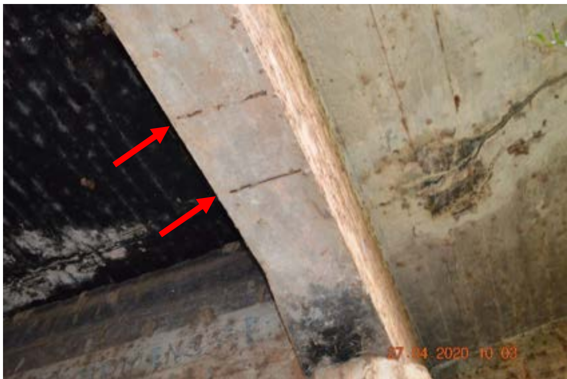
Identificação: Fotografia 10 – Lixiviação, exposição e corrosão das armaduras com pequena perda de área de aço devido ao pequeno cobrimento das armaduras.
