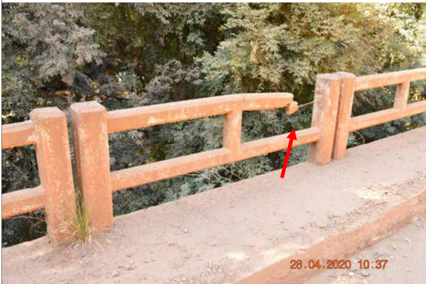
Identificação: Fotografia 4 – Início de lixiviação devido o pequeno comprimento do buzinode.
