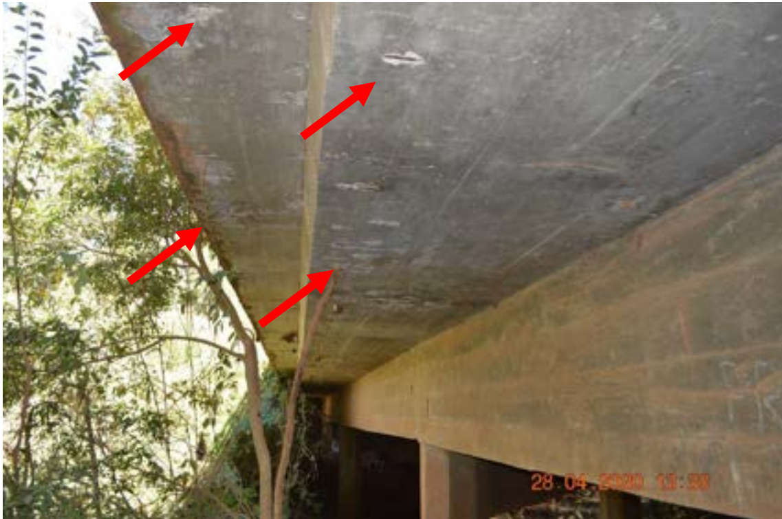
Identificação: Fotografia 9 – Exposição de armadura de costela e corrosão superficial sem perda de seção transversal das barras de aço devido ao baixo cobrimento das armaduras.
