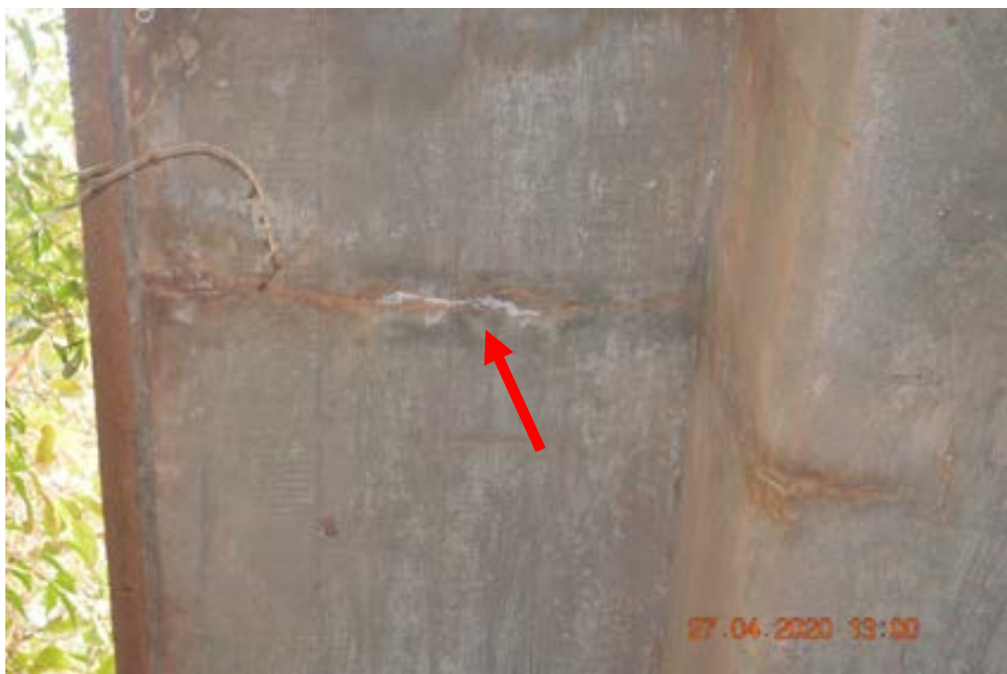
Identificação: Fotografia 4 – Lixiviação superficial no concreto.
