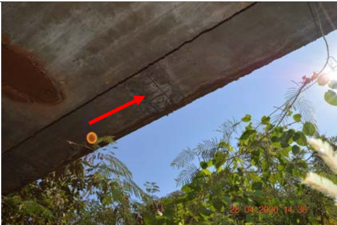
Identificação: Fotografia 4 – Lixiviação devido a ausência de pingadeira com exposição de armadura e corrosão superficial sem perda de seção transversal das barras de aço. Início de lixiviação devido o pequeno comprimento do buzinode.
