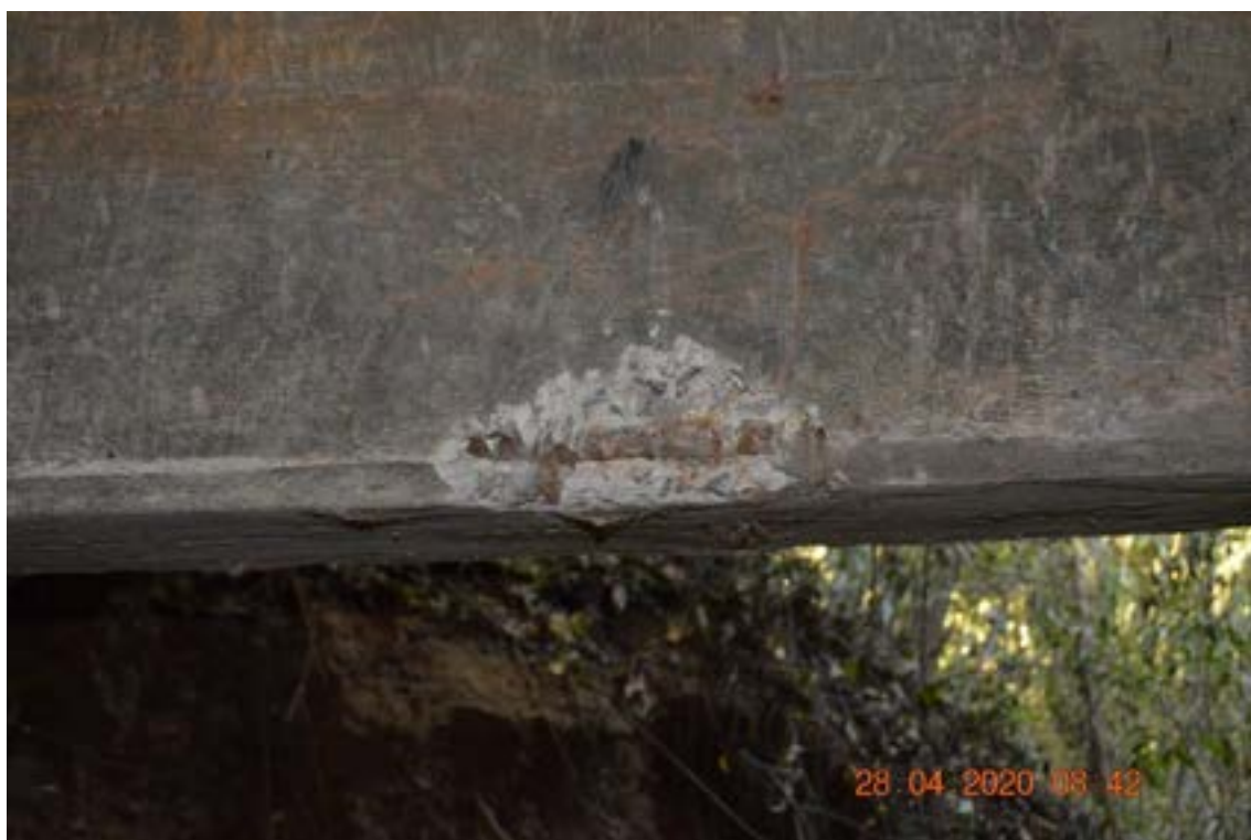
Identificação: Fotografia 4 – Falha de concretagem com armadura exposta com corrosão superficial sem perda de área de aço.
