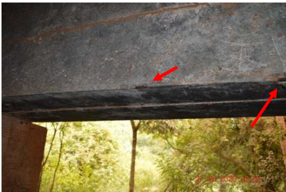
Identificação: Fotografia 8 – Exposição e corrosão das armaduras com pequena perda de área de aço devido o pequeno cobrimento das armaduras na longarina 2.
