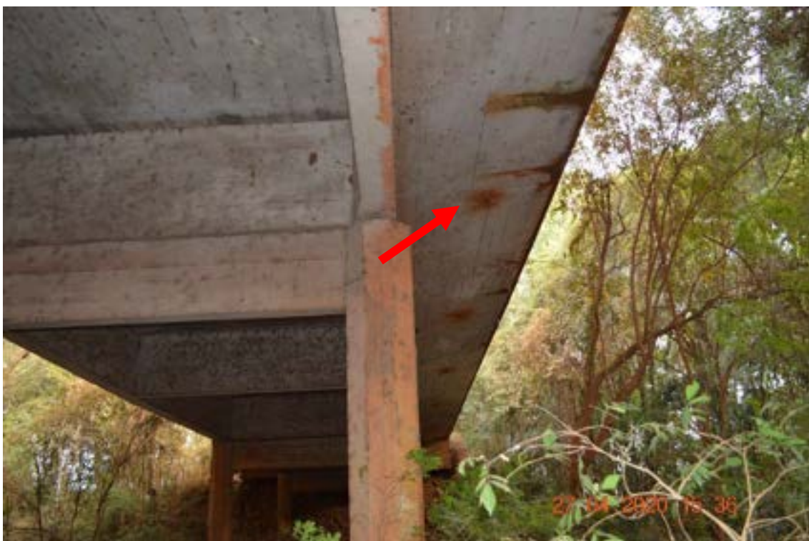
Identificação: Fotografia 10 – Lixiviação devido à ausência da tubulação do buzinode.
