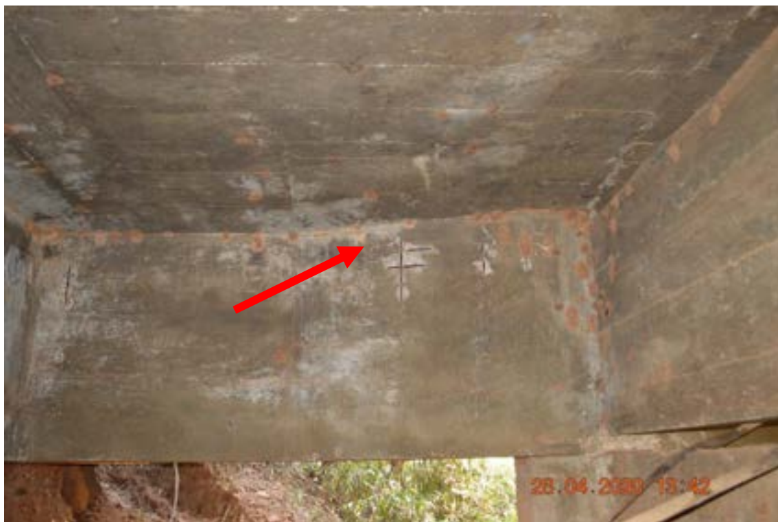
Identificação: Fotografia 11 – Armadura exposta devida a falha de concretagem, sem evidências de corrosão de armaduras.
