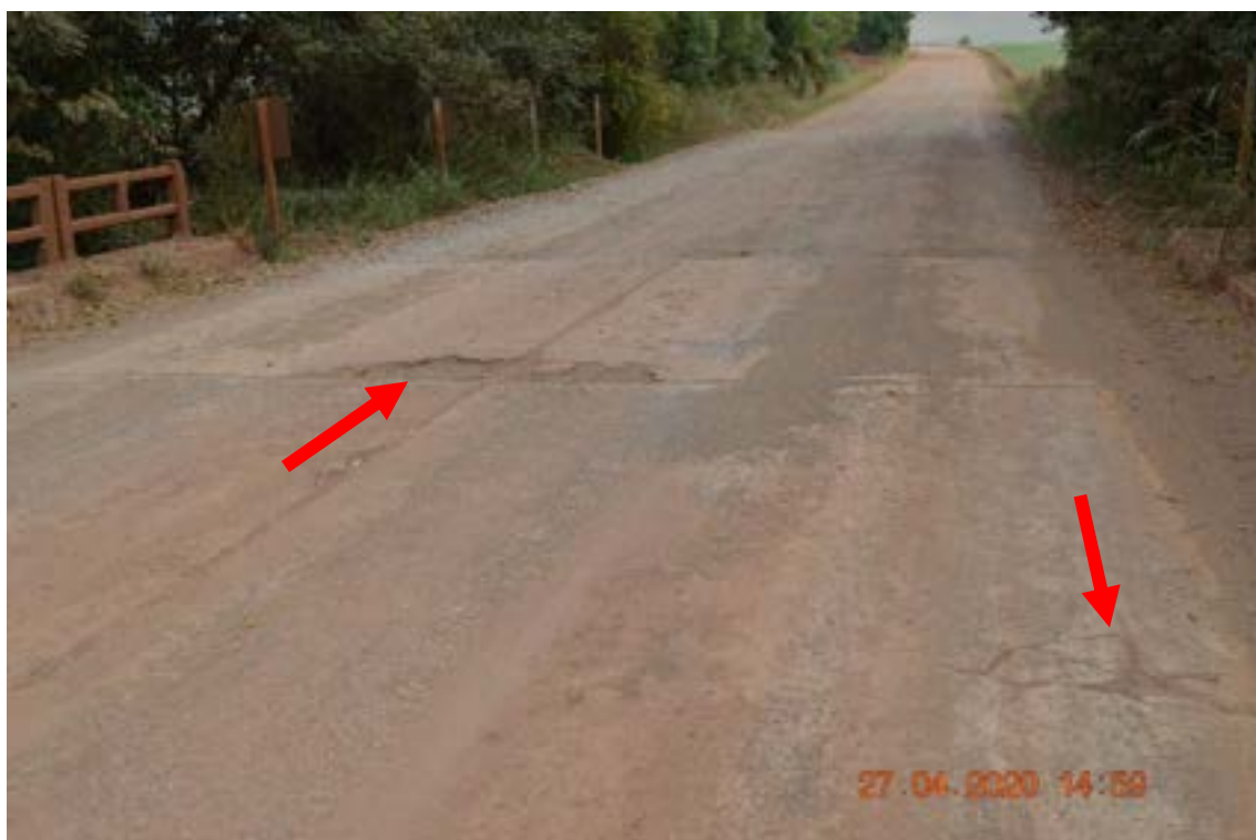
Identificação: Fotografia 6 – Adensamento expressivo na região dos encontros da OAE.
