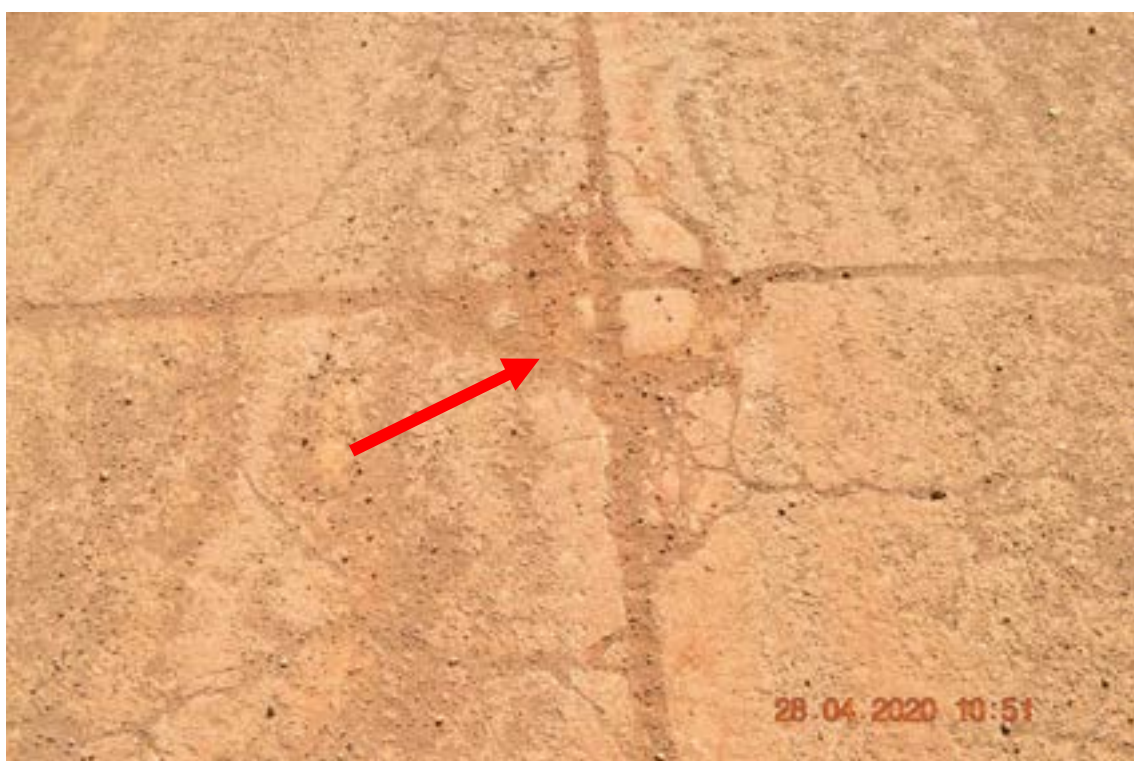
Identificação: Fotografia 8 – Esmagamento do concreto do pavimento.
