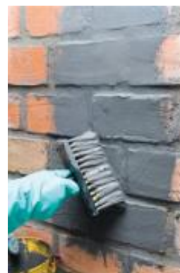
Figura 7 - Aplicação de cristalizante na forma de pintura.
