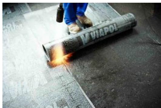
Figura 16 - Execução de manta asfáltica com maçarico.
