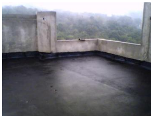
Figura 15 - Imprimação da superfície.
