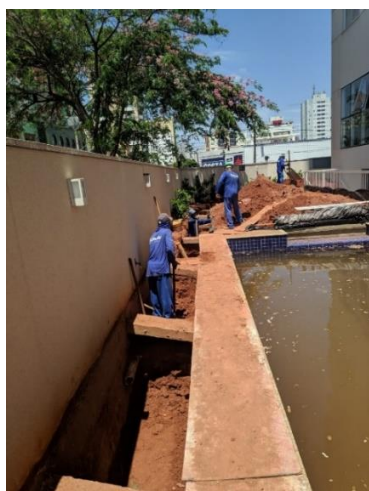
Figura 22 - Execução do reparo
