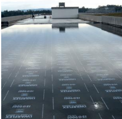
Figura 17 - Teste de estanqueidade.
