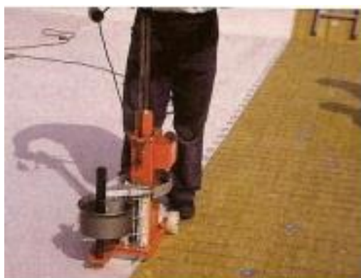
Figura 18 - Fixação automática com parafusos e arruelas especiais.
