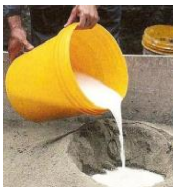
Figura 6 - Preparo da argamassa com o aditivo hidrófugo.
