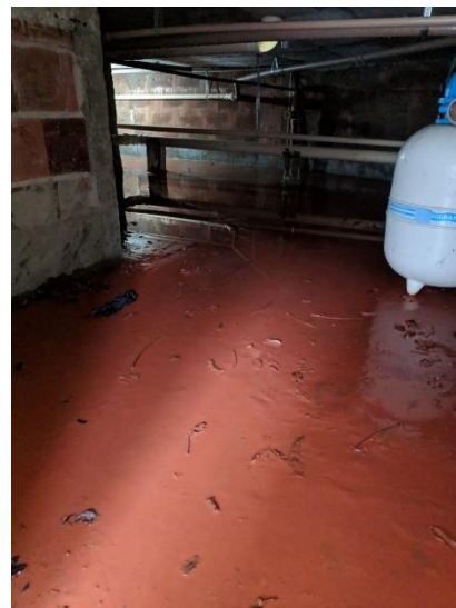
Fonte: Síndico Edifício A (2019).
