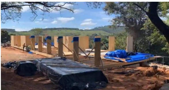
Figura 11 – Montagem dos Pilares e vedações
