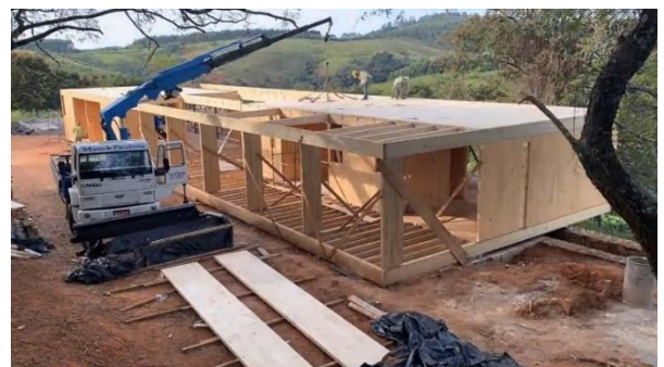
Figura 16 – Montagem da cobertura
