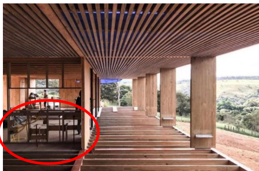
Figura 18 – Construção do sistema hidrossanitário em woodframe .
