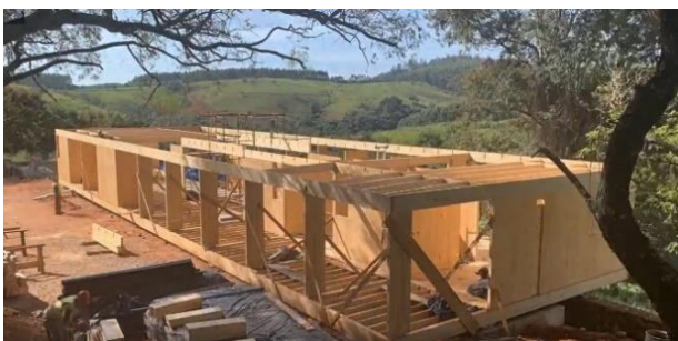
Figura 13 – Montagem das vigas de cobertura
