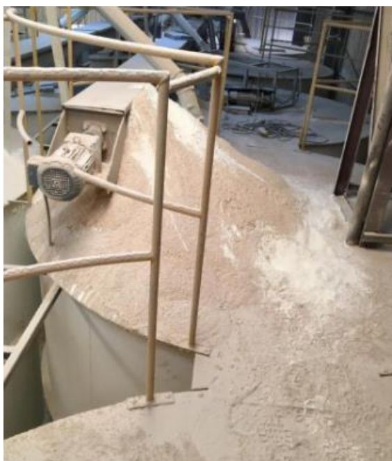
Figura 10 – Chão de Fábrica Sujo
