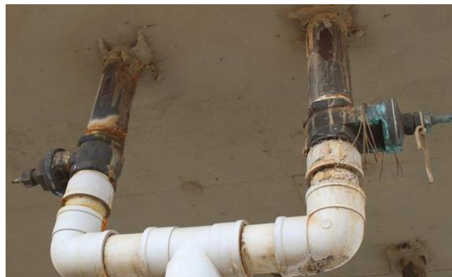
Figura 18 – Tubulações do barrilete com vazamento.
