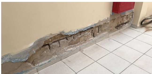
Figura 16 – Viga invertida com armadura exposta em estado avançado de corrosão e deslocamento do concreto de cobertura.
