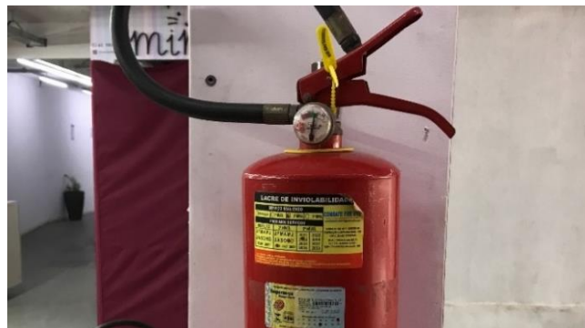
Figura 17 – Extintor com data de validade vencida.
