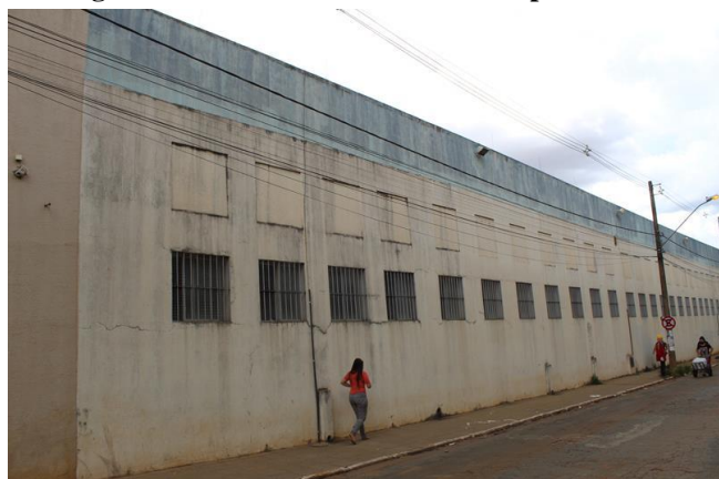
Figura 1 – Vista lateral do imóvel inspecionado.
