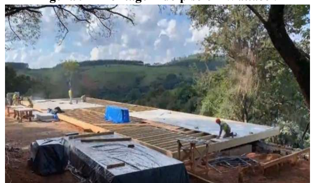
Figura 9 - Montagem do piso em Walldeck
