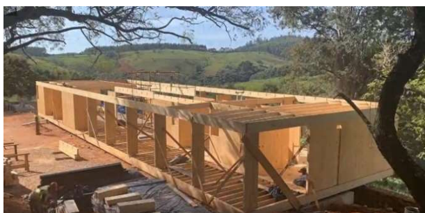
Figura 13 – Montagem das vigas de cobertura
