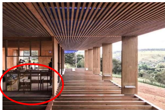
Figura 18 – Construção do sistema hidrossanitário em woodframe .
