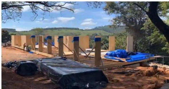
Figura 11 – Montagem dos Pilares e vedações
