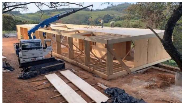
Figura 16 – Montagem da cobertura
