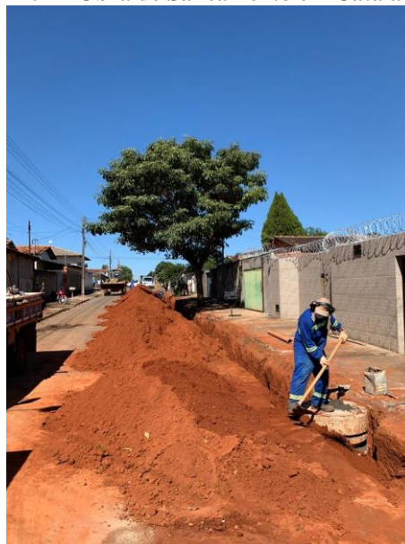
Imagem 02 – Obra de Saneamento em Catalão – GO.
