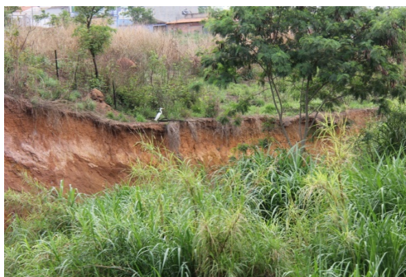
c) P5: Processo erosivo na Av. das Pirâmides, erosão por ravinamento e solapamento.
