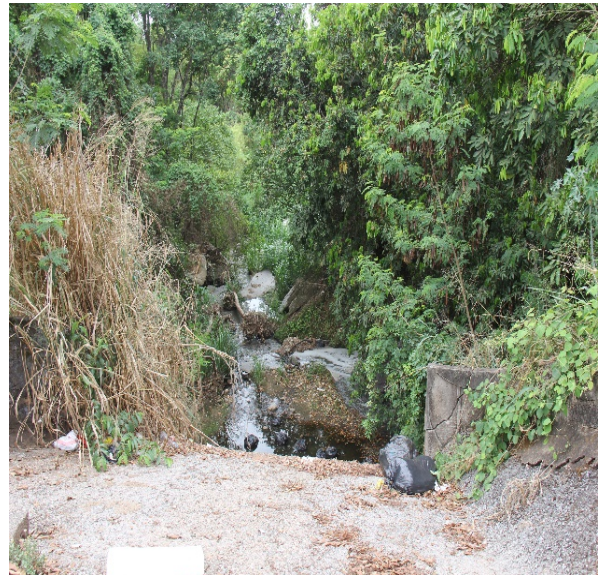
b) P2: local sobre a ponte na Avenida Topázio.
