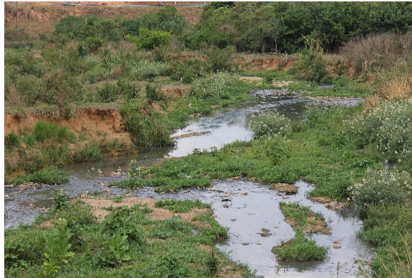
a) P6: na margem esquerda, uma área assoreada, com processos erosivos evidentes.
