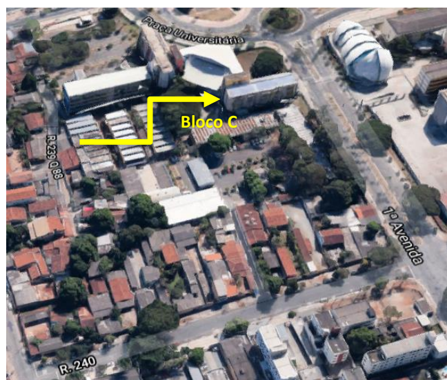
Figura 3 – Localização do objeto de inspeção.
