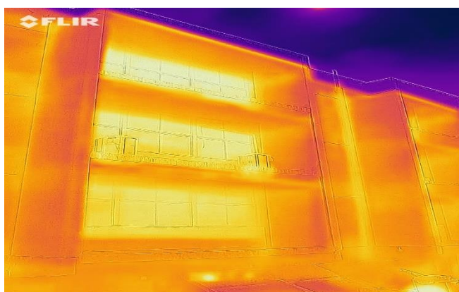
Figura 7 – Termografia do módulo A.
