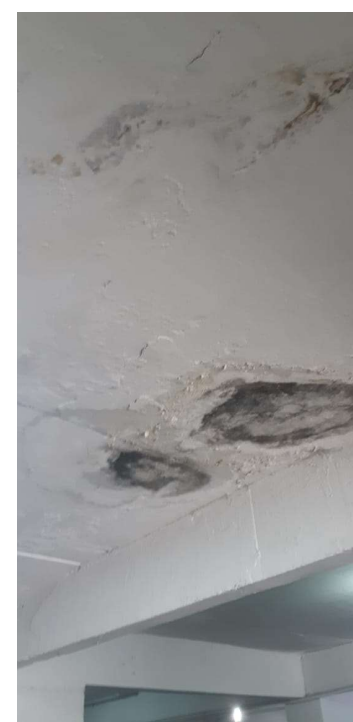
Figura 9 – Infiltrações laje do subsolo
