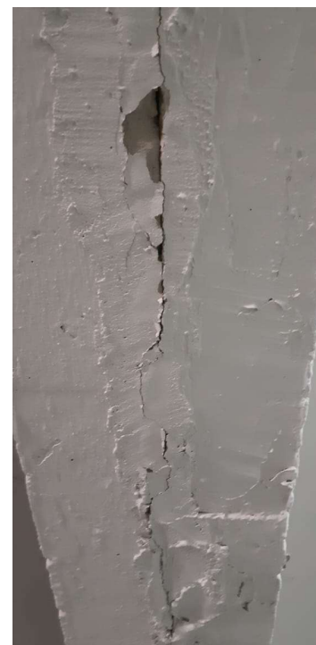
Figura 8 – Emassamento da junta de dilatação
