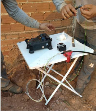
Figura 30. Máquina de fusão.
