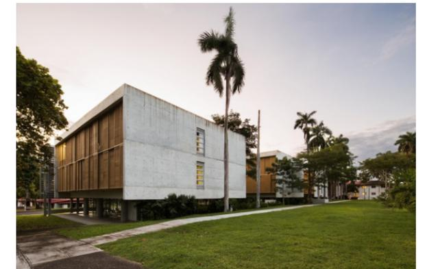
Outro ponto importante como referência foi a estrutura, que se desenvolve em uma malha de 7,50 x 3,60 m e dois balanços de 2,50 m. Cada um dos blocos de alojamentos tem estrutura em concreto armado, moldado 'in loco' e no térreo em pilotis, possibilitando maior flexibilidade aos espaços de uso comum.
