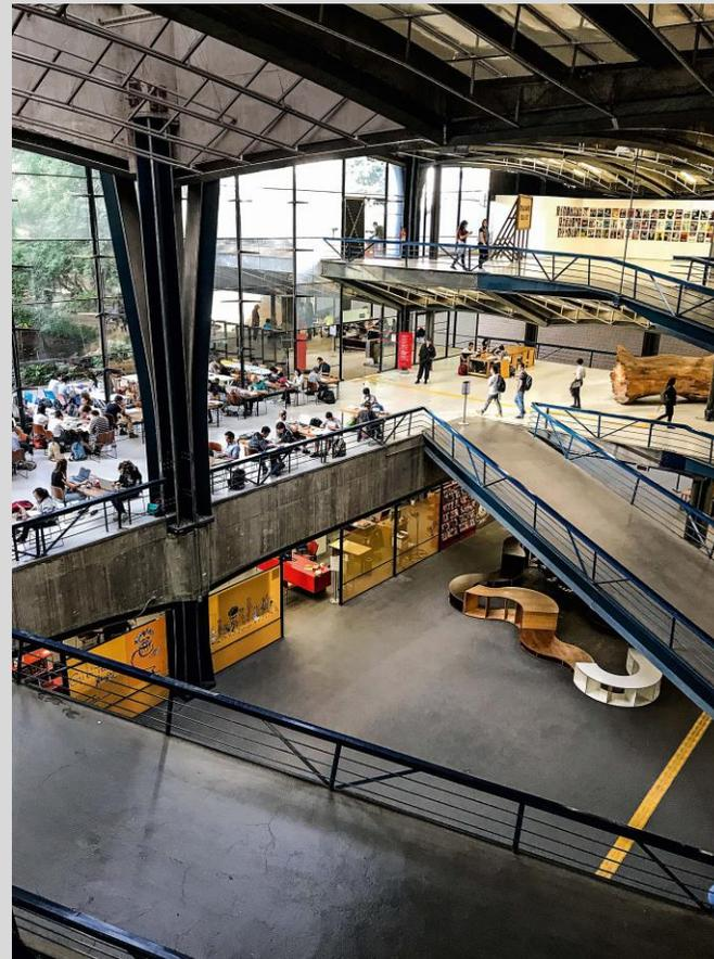
O aço foi, portanto, empregado como reforço estrutural, elemento Visual, estrutura de dimensões reduzidas nos acervos exposições e, nas bases das Vigas, como forma de concreta agem, garantindo melhor acabamento das peças. O encontro preciso entre vigas e a forma como pousam sobre os pilares revelam que além da técnica, a intenção estética era essencial.
