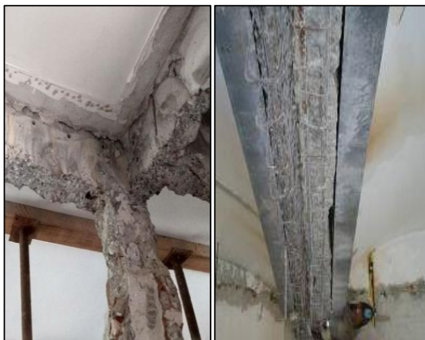
Figura 5 - Desgaste da estrutura – apicoamento
