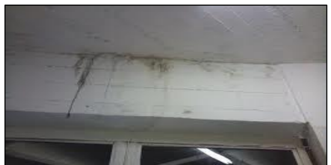
Figura 1: Infiltração
