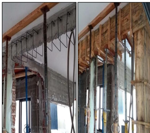
Figura 6: Adição de armadura e formas
