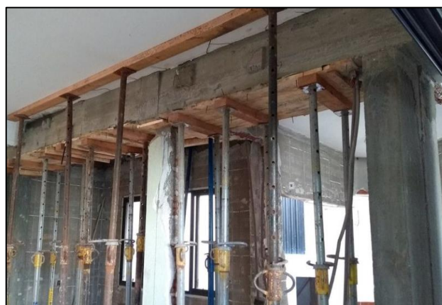
Figura 7: Estrutura já reforçada
