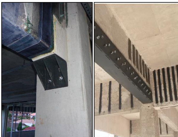
Figura 8: Adição de chapa metálica
