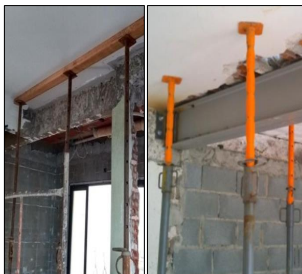
Figura 4: Alívio da tensão – Reescoramento
