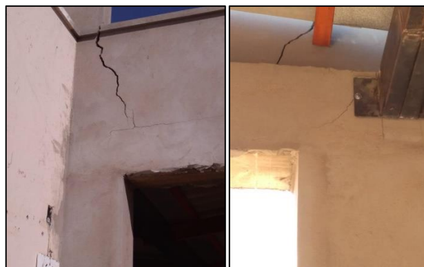
Figura 10: Trincas externas e internas na viga V1
