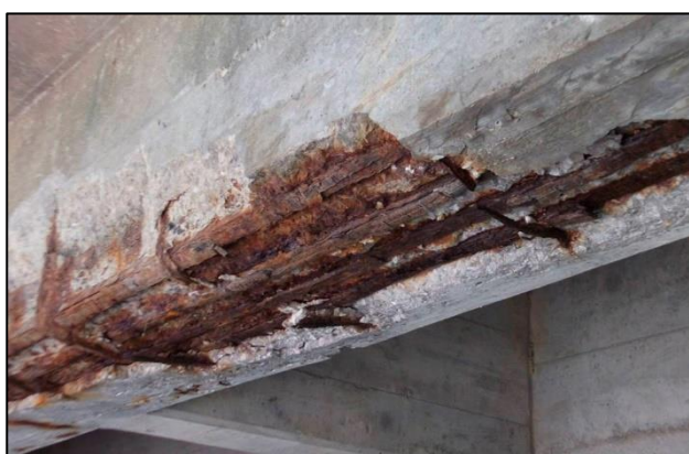
Figura 3: Corrosão
