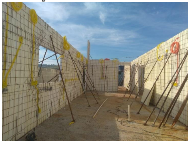
Figura 02 – Radier e Painéis em EPS
