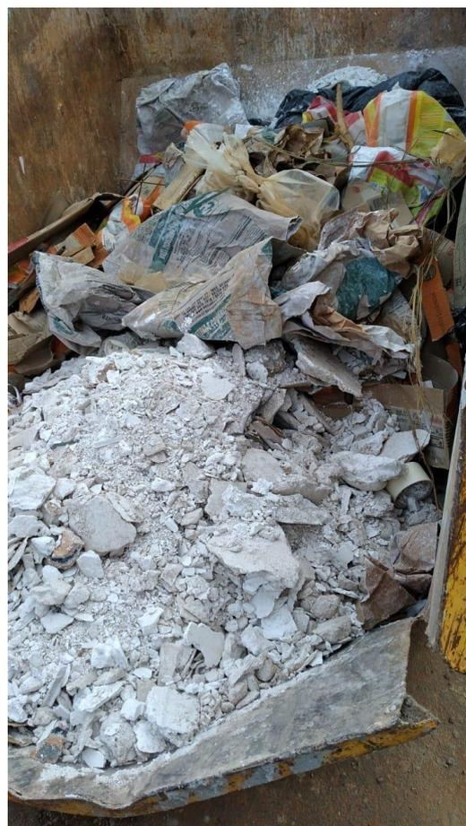
**Figura 14 – Caçamba da Construtora “D” sem separação das classes dos resíduos. Fonte: Construtora “D” (2021)**
