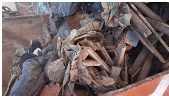
**Figura 10 – Caçamba sem segregação de resíduos. Fonte: Construtora “B” (2021)**
