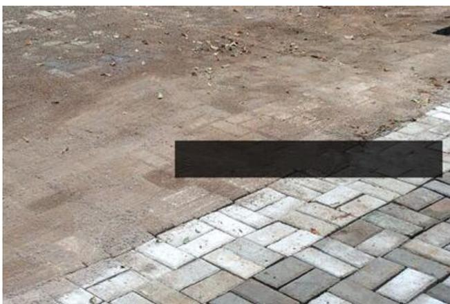
**Figura 20 – Aplicação dos agregados reciclados para assentamento de paver. Fonte: Página virtual da Usina de Reciclagem (2021)**
