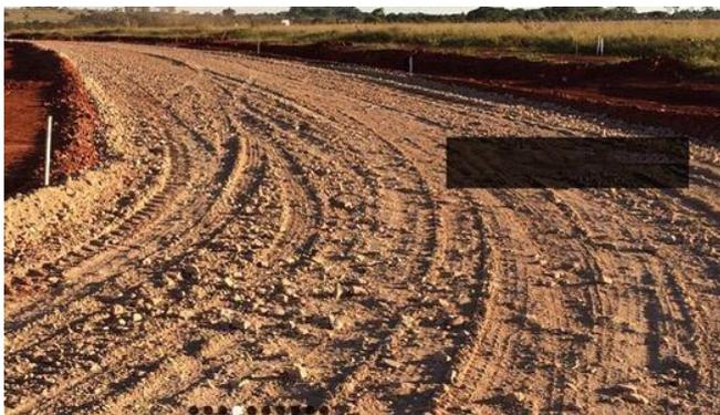
**Figura 19 – Aplicação dos agregados reciclados para sub-base. Fonte: Página virtual da Usina de Reciclagem (2021)**
