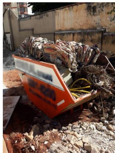
**Figura 9 – Caçamba sem segregação de resíduos. Fonte: Construtora “B” (2021)**
