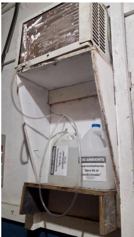
**Figura 8 – Reaproveitamento de água do ar condicionado. Fonte: Construtora “A” (2021)**
