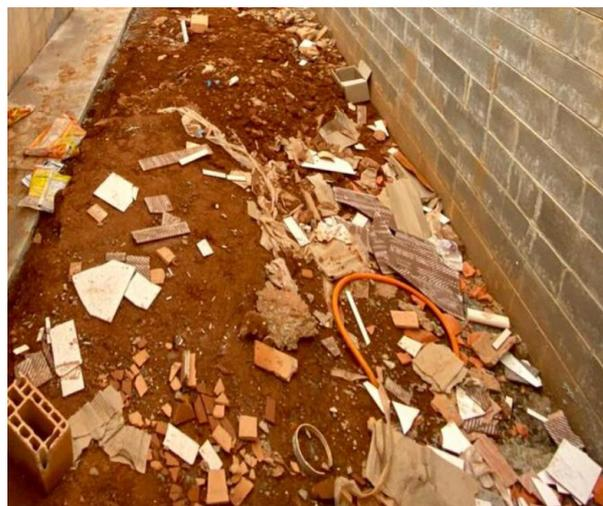
**Figura 13 – Canteiro da Construtora “D” sem separação e armazenamento de resíduos. Fonte: Construtora “D” (2021)**
