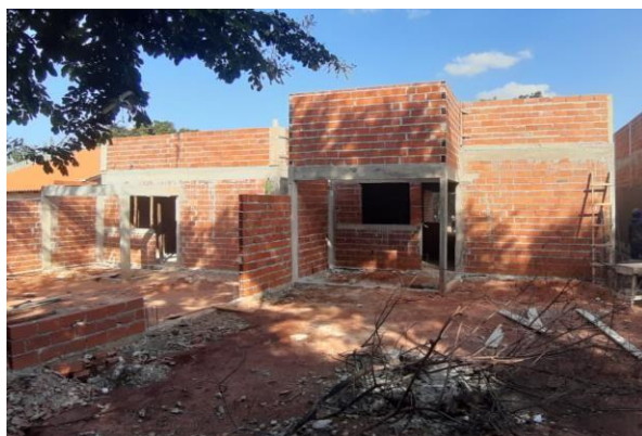
Figura 10 - Alvenaria de vedação de blocos cerâmicos. Fonte: Dos autores, 2020.
