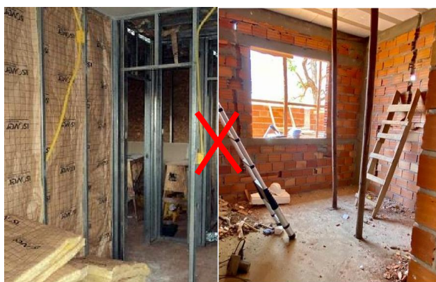
Figura 1 – Diferentes sistemas construtivos: alvenaria convencional e drywall. Fonte: Dos autores, 2020.
