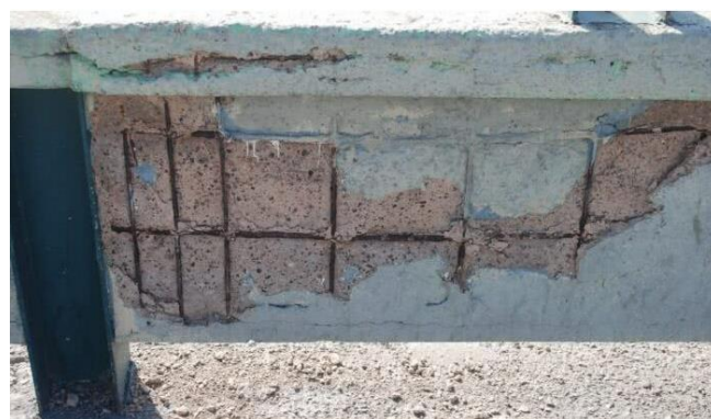
Figura 05. Representação genérica de um ninho de concretagem
