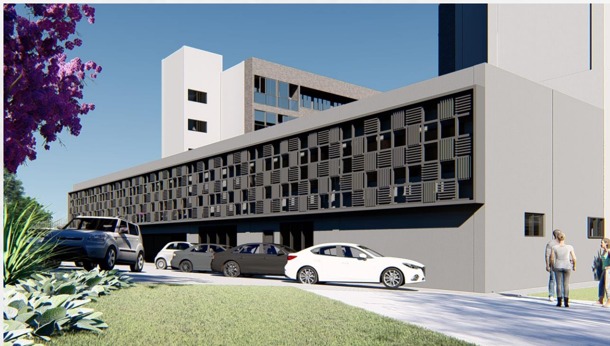
Fachada leste- elemento vazado de proteção contra insolação em janelas de vidro.
