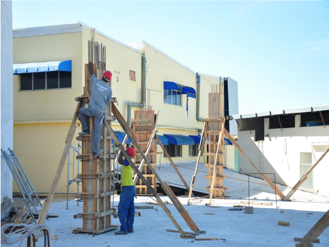
Figura 3 – Trabalho sendo realizado pelos detentos da penitenciária do Espírito Santo
