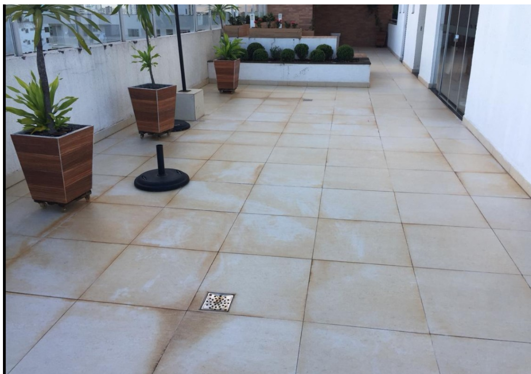
Figura 8 - Manchamento do piso cerâmico - Fonte: Os autores (2020).
