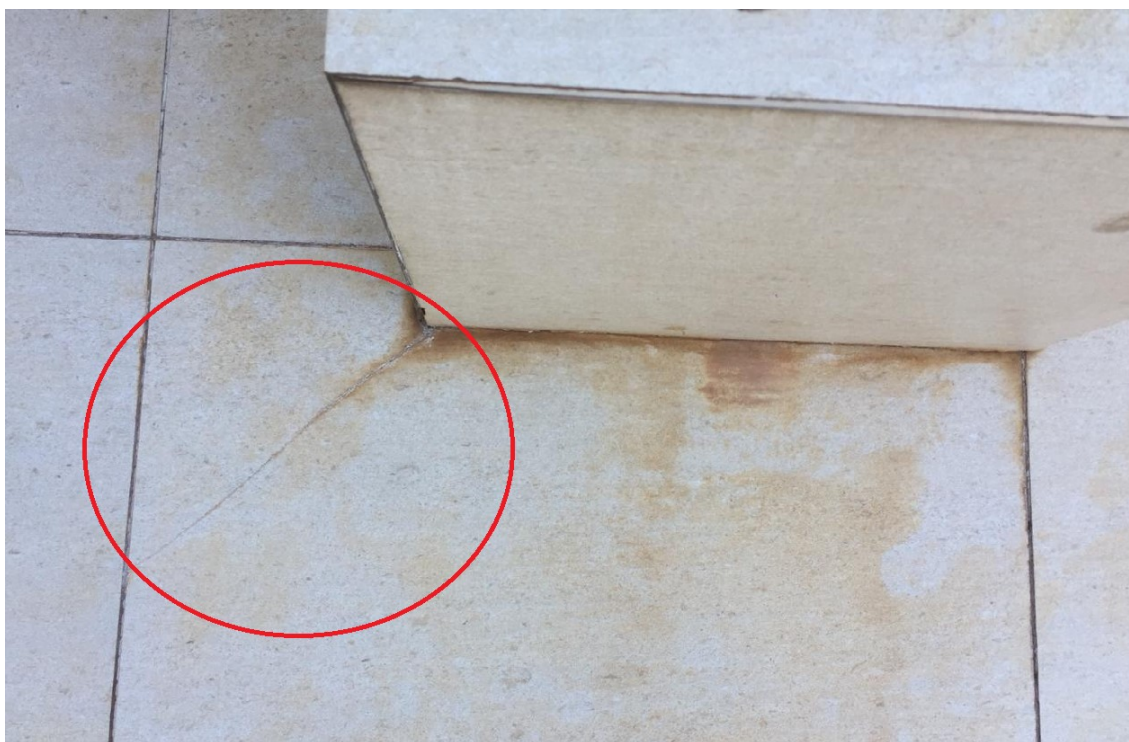
Figura 10 - Trinca no piso cerâmico - Fonte: Os autores (2020).
