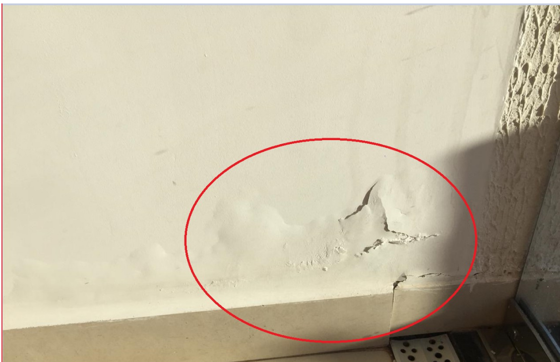
Figura 7 - Empolamento e destacamento da pintura - Fonte: Os autores (2020).
