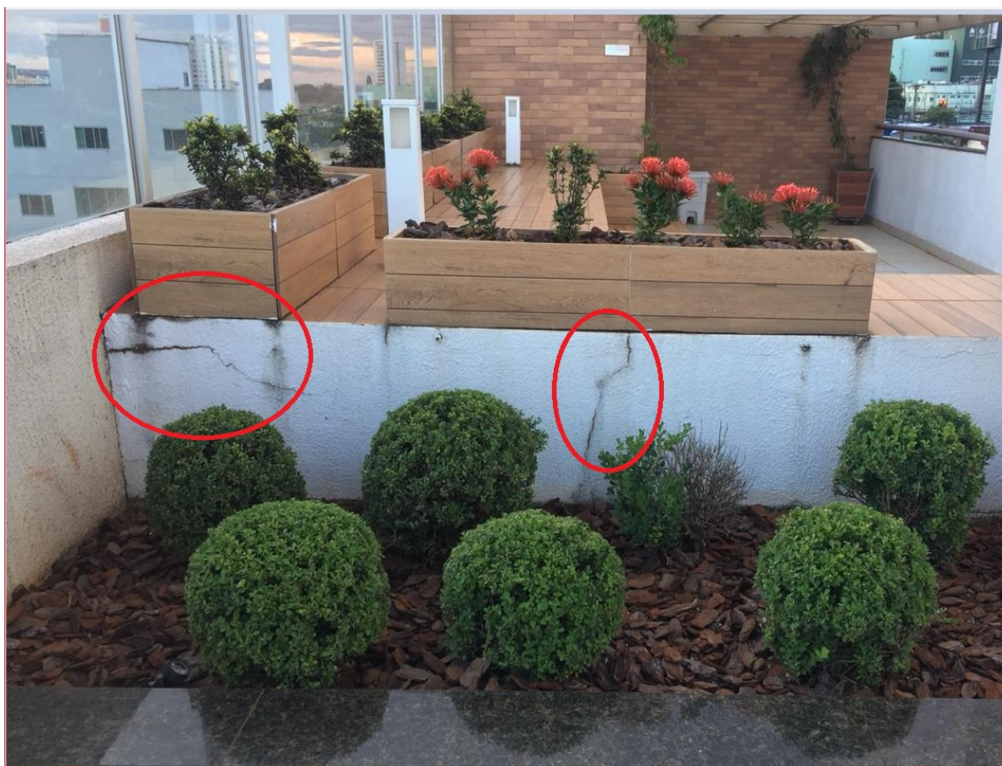
Figura 11 - Fissura higrotérmica e manchamento - Fonte: Os autores (2020).
