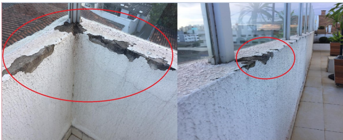
Figura 13 - Fissuras higrotérmicas e descolamento dos revestimentos - Fonte: Os autores (2020).
