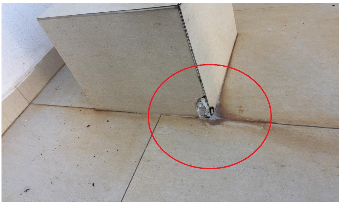
Figura 9 - Destacamento do piso cerâmico - Fonte: Os autores (2020).
