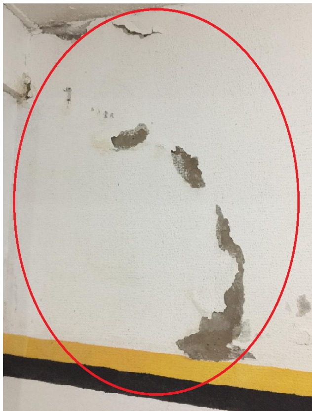
Figura 14 - Empolamento, destacamento da pintura e perda de estanqueidade - Fonte: Os autores (2020).
