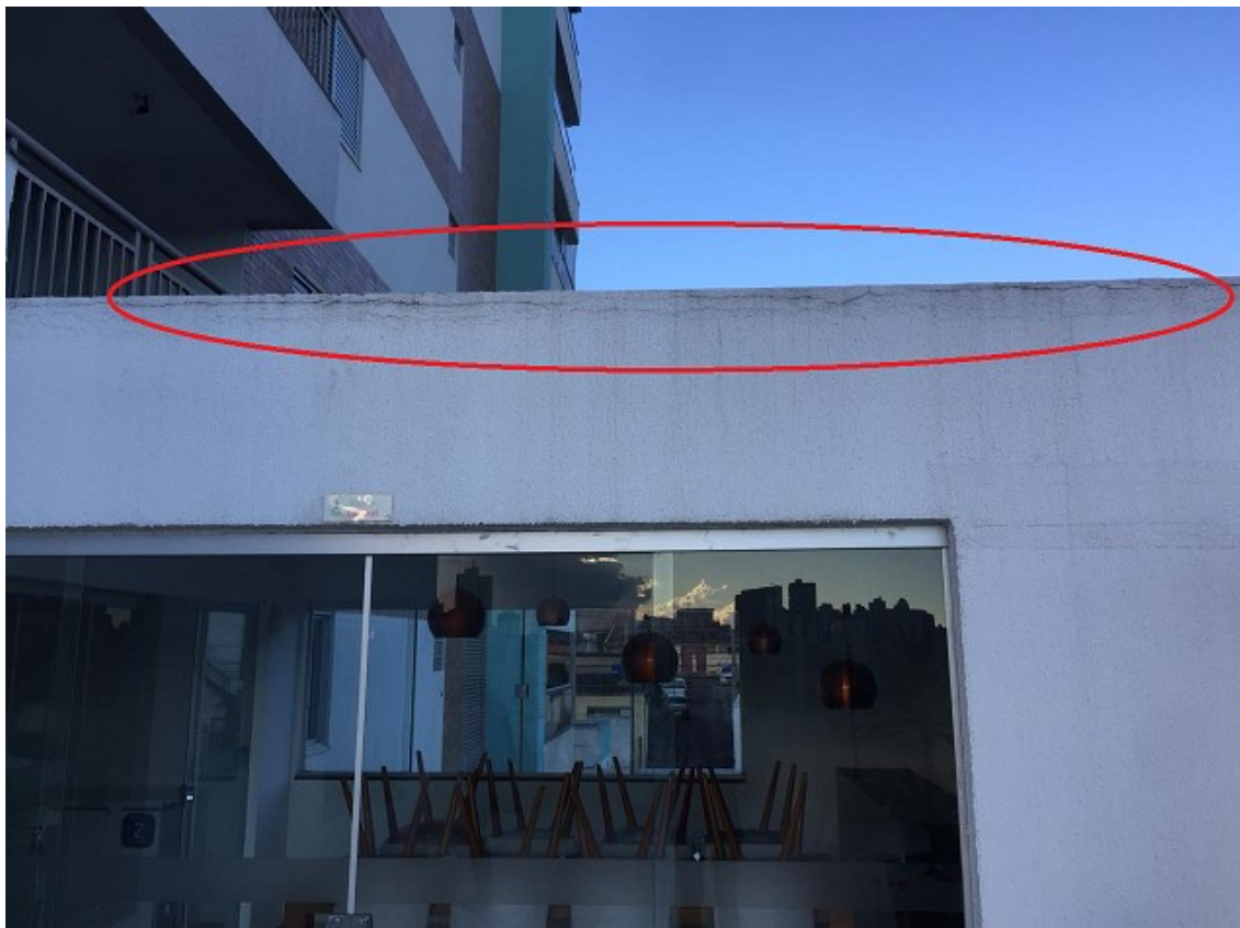
Figura 12 - Fissuras higrotérmicas - Fonte: Os autores (2020).
