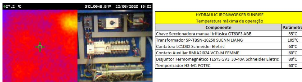
Figura 10 - Quadro Elétrico da Hydraulic Ironworker com as temperaturas máximas de operação
