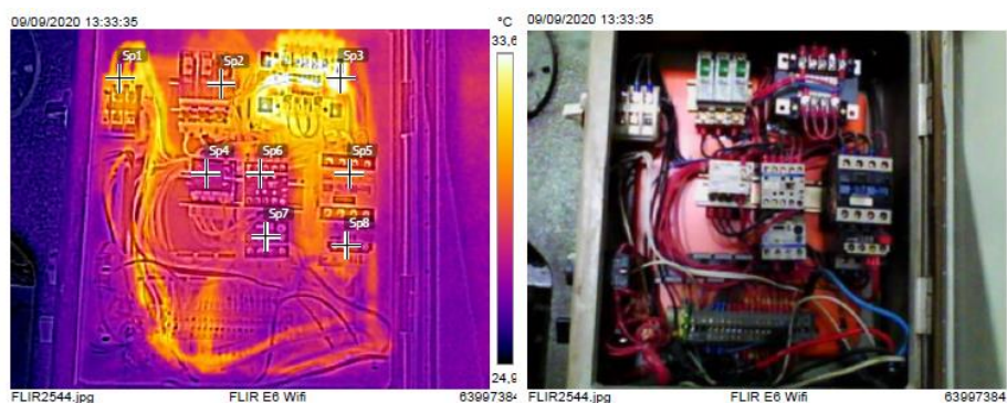
Figura 14 - Quadro Elétrico Dobradeira Elétrica Newton (2ª manutenção preditiva)
