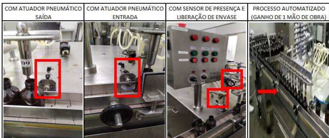
Figura 12: Instalação do atuador pneumático
