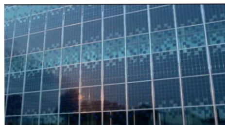
Exemplo Cortina fotovoltaica. Fonte: <https://www.onyxosolar.com/solar-pv-curtain-wall/>
