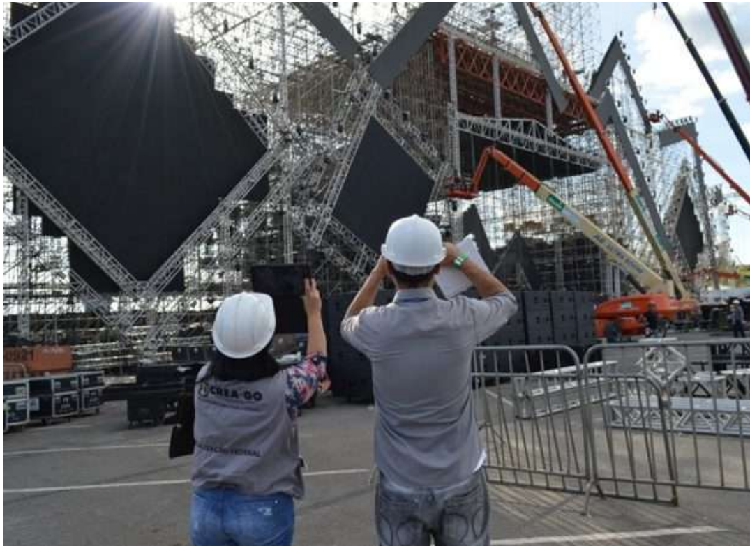
Vistoria de estrutura. Foto: Crea-GO
