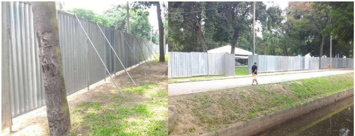
Tapumes metálicos. Fonte: Site Luso Brasileira, locação de tendas e estruturas
