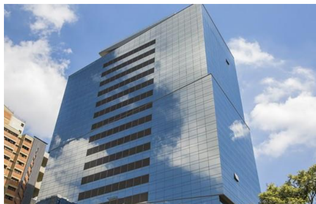
Figura 8: Fachada Envidraça Sistema Unitizado.
