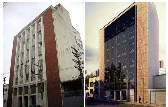
Figura 2: Antes e depois da execução de retrofit.
