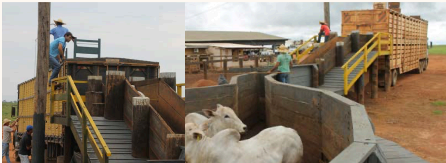
Figura 15 - Estrutura do embarcadouro
