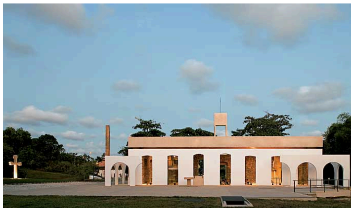
Imagem 27: Imagem lateral da capela
