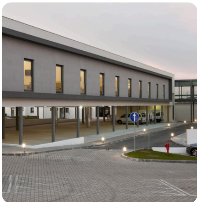
Figura 08: Imagem Segundo Pavimento
