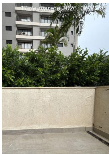
Figura 4 - Deterioração do revestimento em parede da área de lazer. Figura 5 – Infiltração por falha de impermeabilização observada em parede de vedação.
