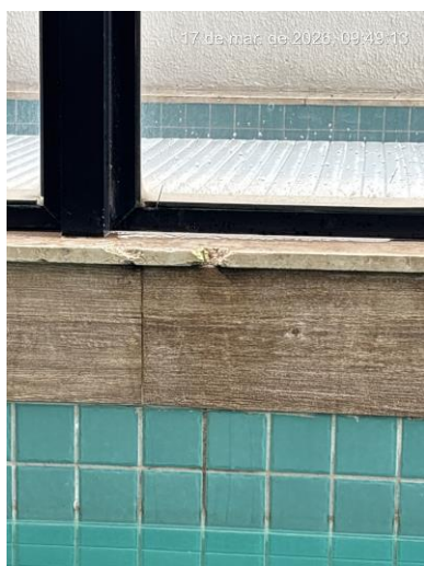
Figura 4 - Deterioração do revestimento em parede da área de lazer. Figura 5 – Infiltração por falha de impermeabilização observada em parede de vedação.
