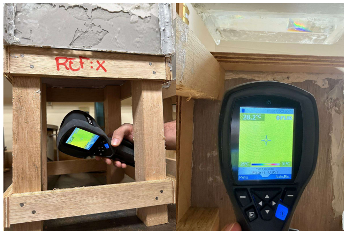
Figura 5 – Inspeção termográfica realizada no protótipo REFERÊNCIA. Fonte: Acervo dos autores (2026).
