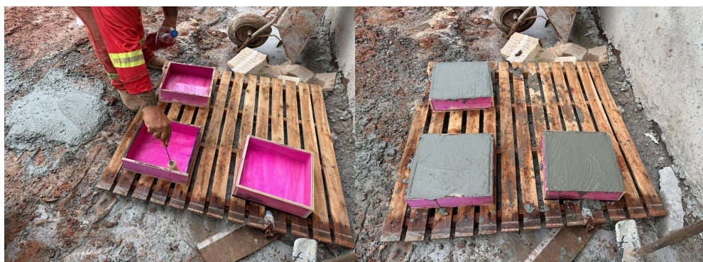
Figura 2: Aplicação de desmoldante nas formas para moldagem e os protótipos de lajes após a concretagem. Fonte: Acervo do autor (2026)
