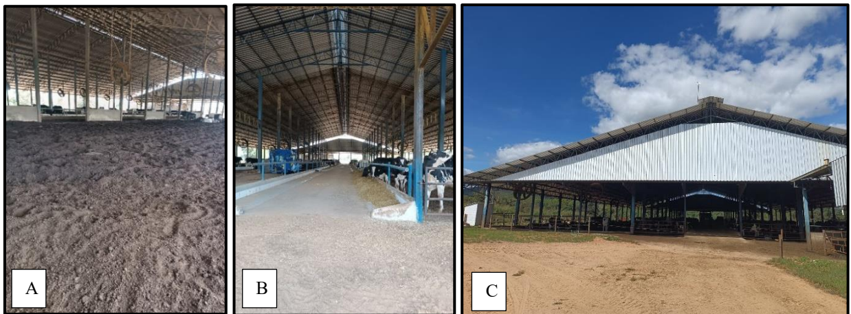
Fig.1 Instalações do sistema Compost Barn da propriedade leiteira avaliada, localizada no estado de Goiás. (A) Área de descanso coletiva com cama compostada por maravalha, com reposição realizada com palha de arroz. (B) Pista de alimentação, separada da área de descanso por muro de alvenaria, onde os animais têm acesso aos comedouros e bebedouros. (C) Vista geral do galpão Compost Barn , orientado no sentido leste-oeste, com ventilação mecânica e estrutura compatível com o bem-estar animal e as exigências do sistema
