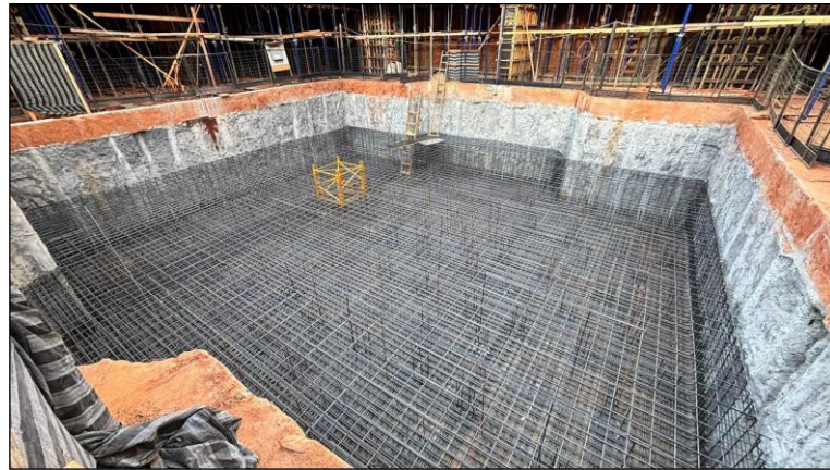
Figura 2: Vista superior da armação do radier estakeado com aço CA-70 (2026).
