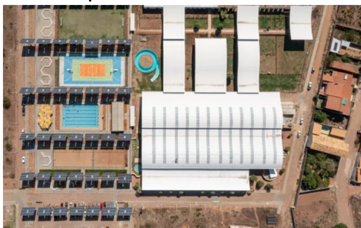
Figura 29: Hospital Veterinário Escola da Unileão. Fonte: Site mdc.arq.
